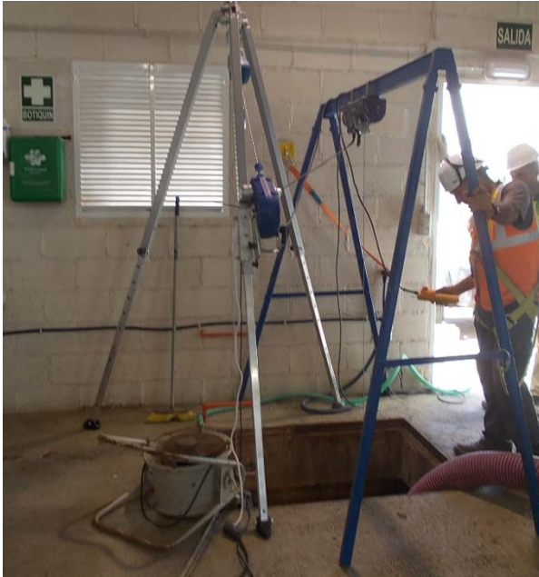
Figura 21. Recurso preventivo vigilando trabajos. Fuente: Autor.
