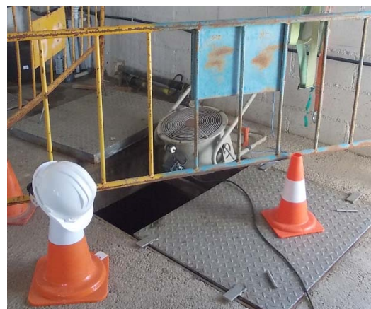
Figura 24. Apertura tapadera 2. Fuente: Autor
