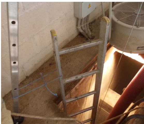
Figura 34. Descenso a EECC por escalera. Fuente: Autor
