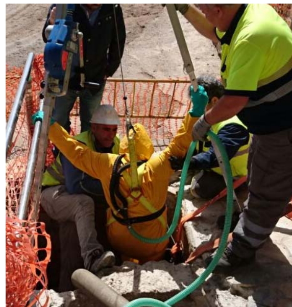
Figura 37. Entrada de trabajador en EECC 2. Fuente: Autor
