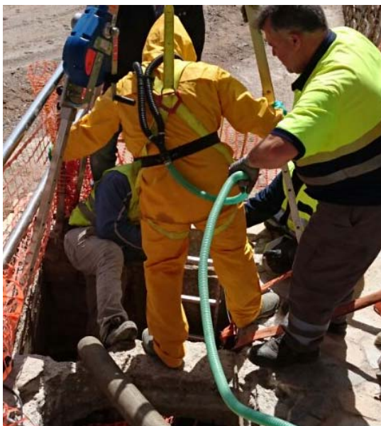
Figura 36. Entrada de trabajador en EECC 1. Fuente: Autor
