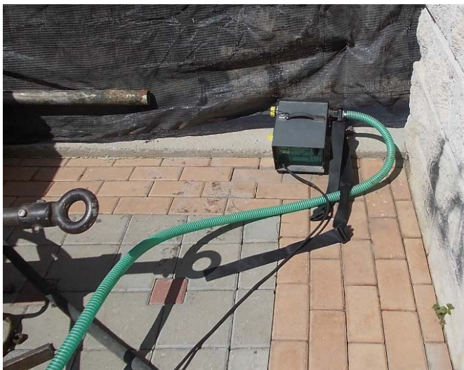
Figura 32. Toma de aire del equipo semiautónomo. Fuente: Autor
