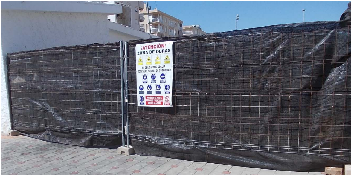
Figura 17. Vallado de obra parte delantera. Fuente: Autor.
