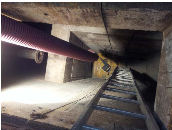
Figura 38. Área de trabajo vista desde el exterior. Fuente: Autor.
