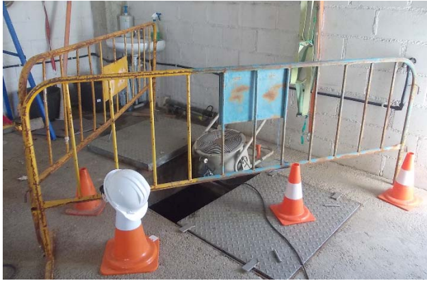
Figura 19. Vallado de señalización de peligros. Fuente: Autor.
