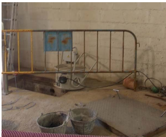
Figura 23. Apertura tapadera 1. Fuente: Autor
