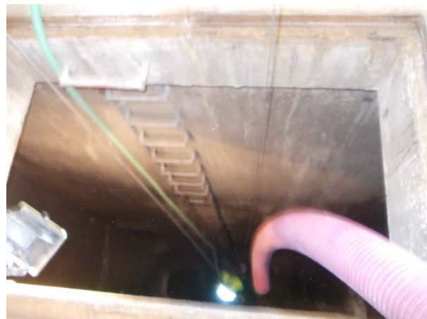
Figura 35. Descenso a EECC por pates Fuente: Autor
