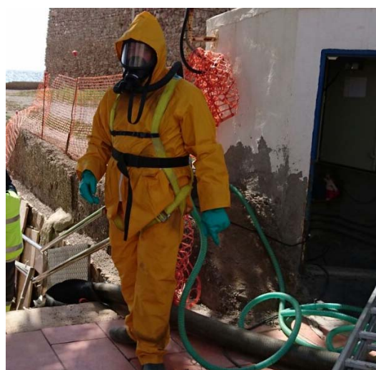
Figura 40. Trabajador antes de entrar al EECC. Fuente: Autor.
