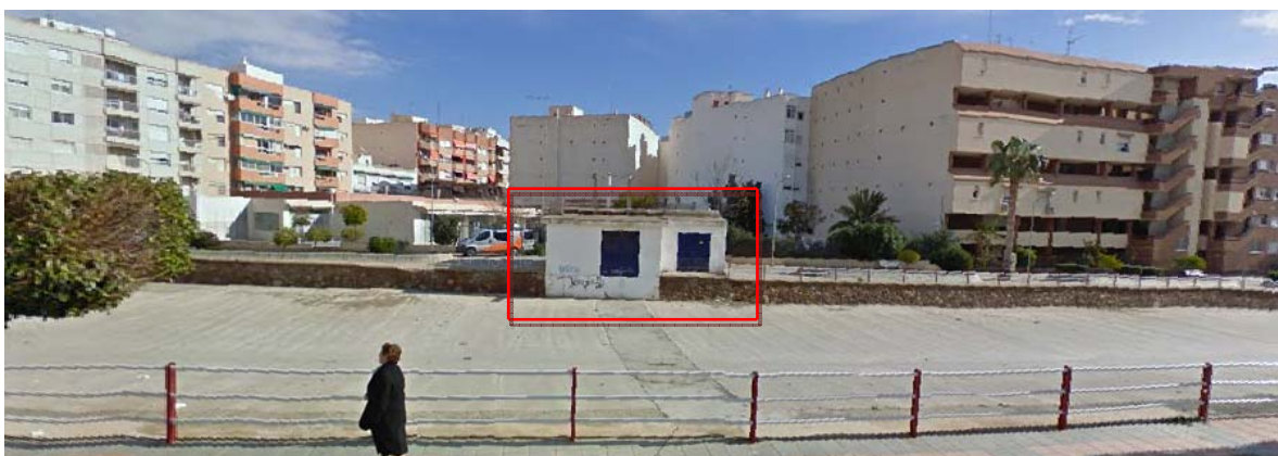
Figura 6. Vista Oeste del pozo de bombeo. Fuente: Autor.
