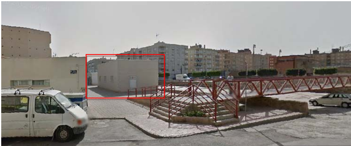
Figura 5. Vista Noreste del pozo de bombeo. Fuente: Autor.
