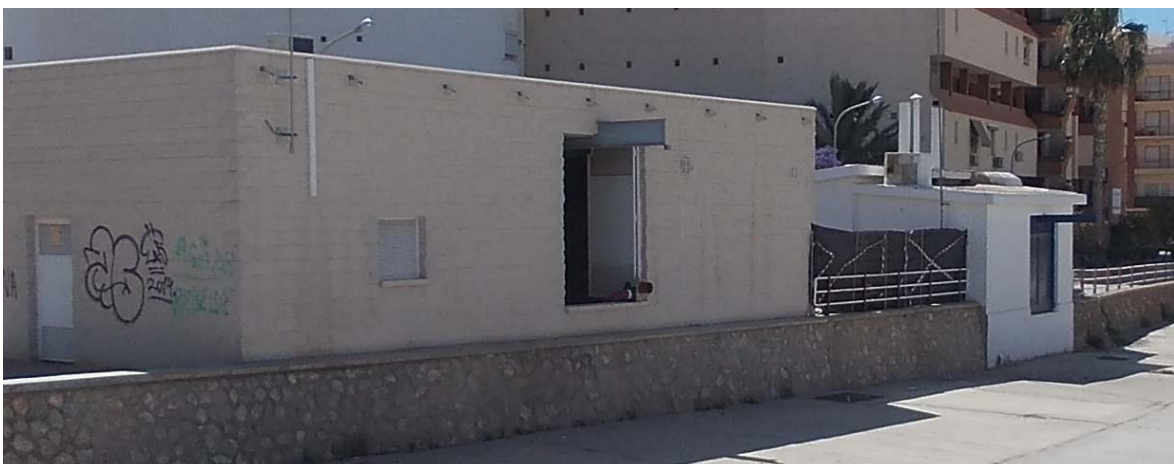
Figura 18. Vallado de obra parte trasera. Fuente: Autor.
