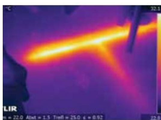
Figura 38: Tubería de ACS bajo pavimento
