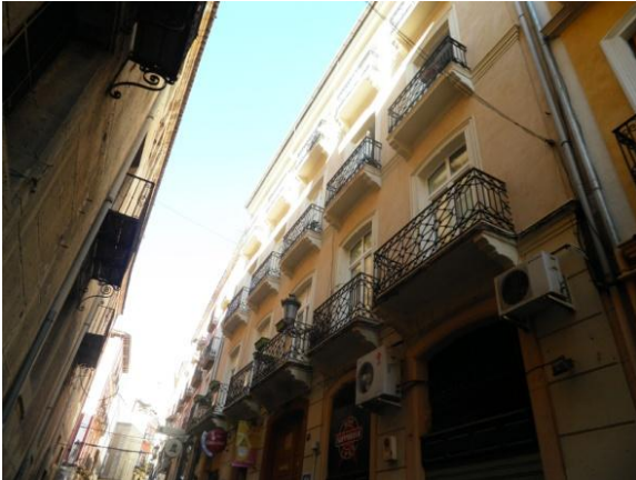
Figura 55: Fachada principal (Fuente: Autora)
