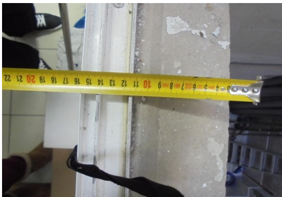
Figura 81: Cerramiento en hueco de patio (Fuente: Autora)
