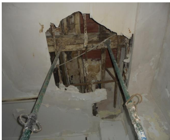
Figura 50: Apuntalamiento de forjado de planta (Fuente: Autora)
