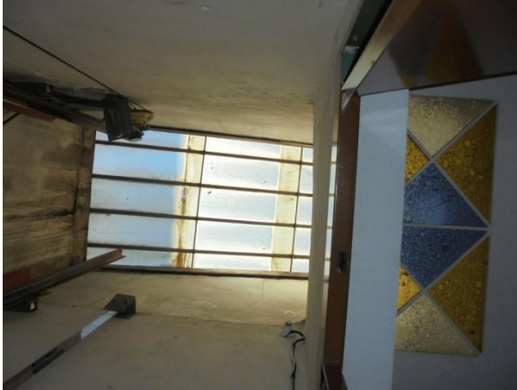
Figura 84: Lucernario en hueco de ascensor. Vista interior (Fuente: Autora)
