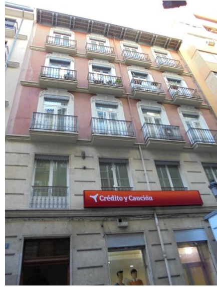
Figura 2: Fachada principal Edificio 2
