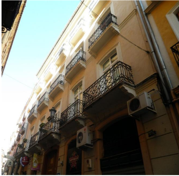
Figura 1: Fachada principal Edificio 1
