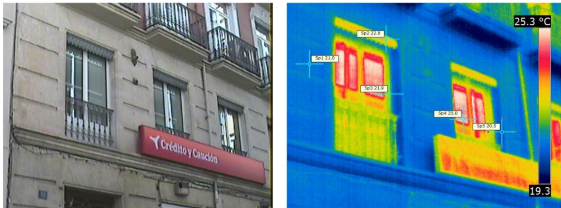
Figura 101: Termografía 7. Fachada homogénea
