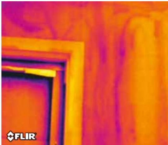
Figura 39: Presencia de plagas en el interior de fábrica (Fuente: Cámaras termográficas FLIR para diagnóstico de edificios (2.014, Pág. 5))
