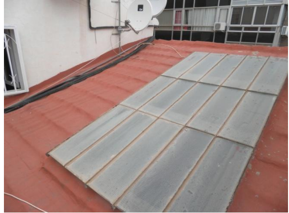
Figura 85: Lucernario en hueco de ascensor. Vista exterior (Fuente: Autora)
