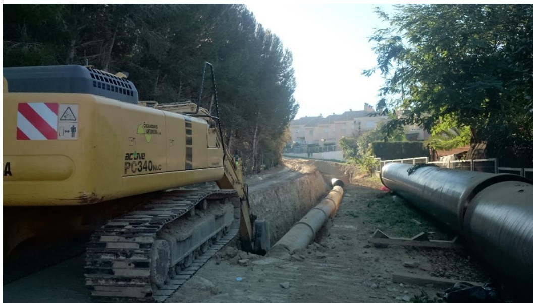
Figura 82. Descubrimiento de tubería. Fuente: Demoliciones D-Tres S.L.L
