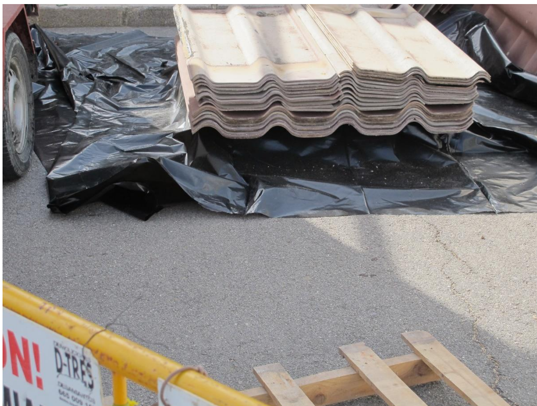
Figura 50. Acopio sobre lámina plástica. Fuente: Elaboración propia
