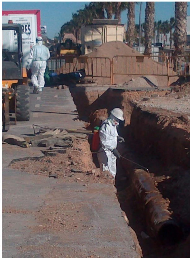
Figura 78. Encapsulación de tubería. Fuente: Demoliciones D-Tres S.L.L
