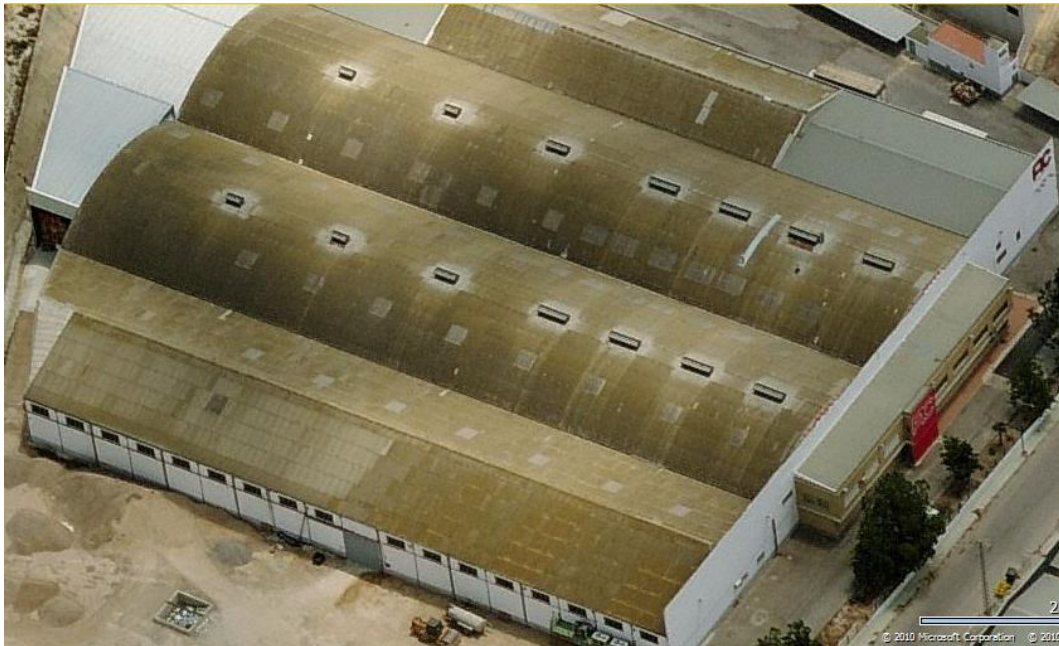
Figura 67. Situación nave industrial con cubierta de amianto. Fuente: Demoliciones D-Tres S.L.L.
