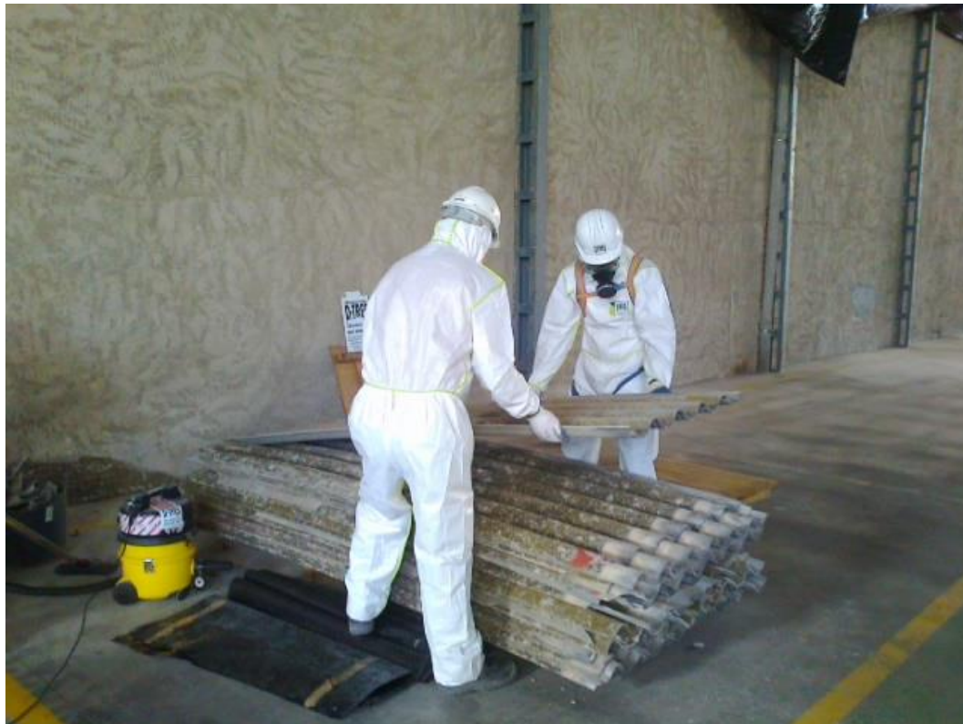
Figura 76. Desmontaje de cubierta de fibrocemento desde plataforma motorizada, desmontaje sobre zona de acopio.
