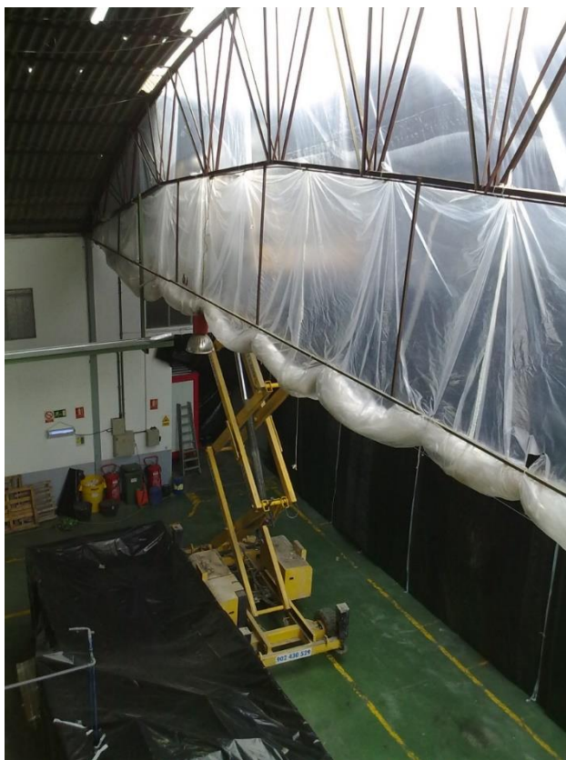
Figura 68. Medidas para evitar dispersión de fibras (compartimentado). Fuente: Demoliciones D-Tres S.L.L.
