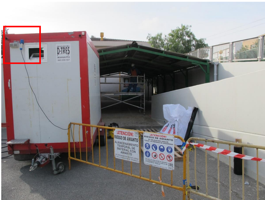
Figura 37. Zona acopio de residuos; conexión a la red eléctrica. Fuente: Elaboración propia.
