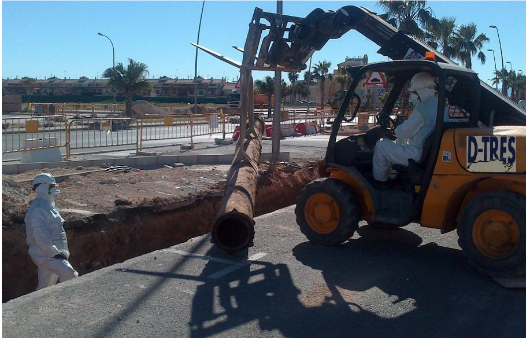
Figura 80. Desmontaje de tubería con maquinaria. Fuente: Demoliciones D-Tres S.L.L
