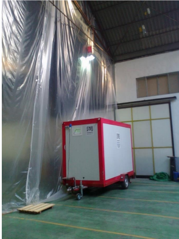
Figura 70. Salida a zona de trabajo compartimentada. Fuente: Demoliciones D-Tres S.L.L.
