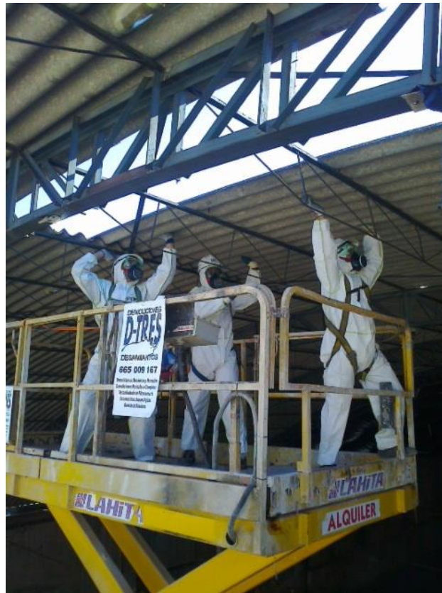
Figura 72. Desmontaje de cubierta de fibrocemento desde plataforma motorizada.
