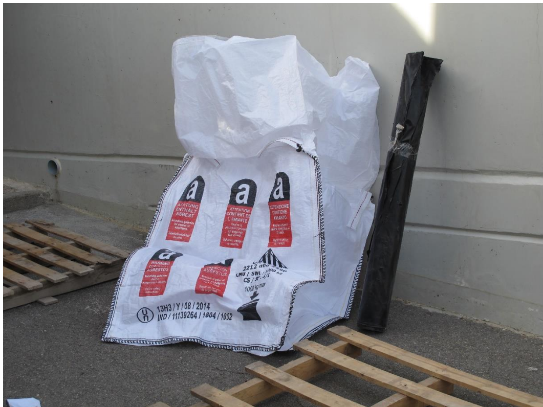
Figura 39. Material para macroencapsular (lámina plástica y saco “BigBag”). Fuente: Elaboración propia.
