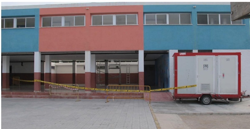
Figura 1. Colocación de UMD en obra. Fuente: Elaboración propia.
