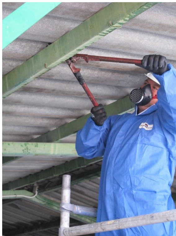
Figura 46. Desmontaje de la cubierta. Fuente: Elaboración propia.
