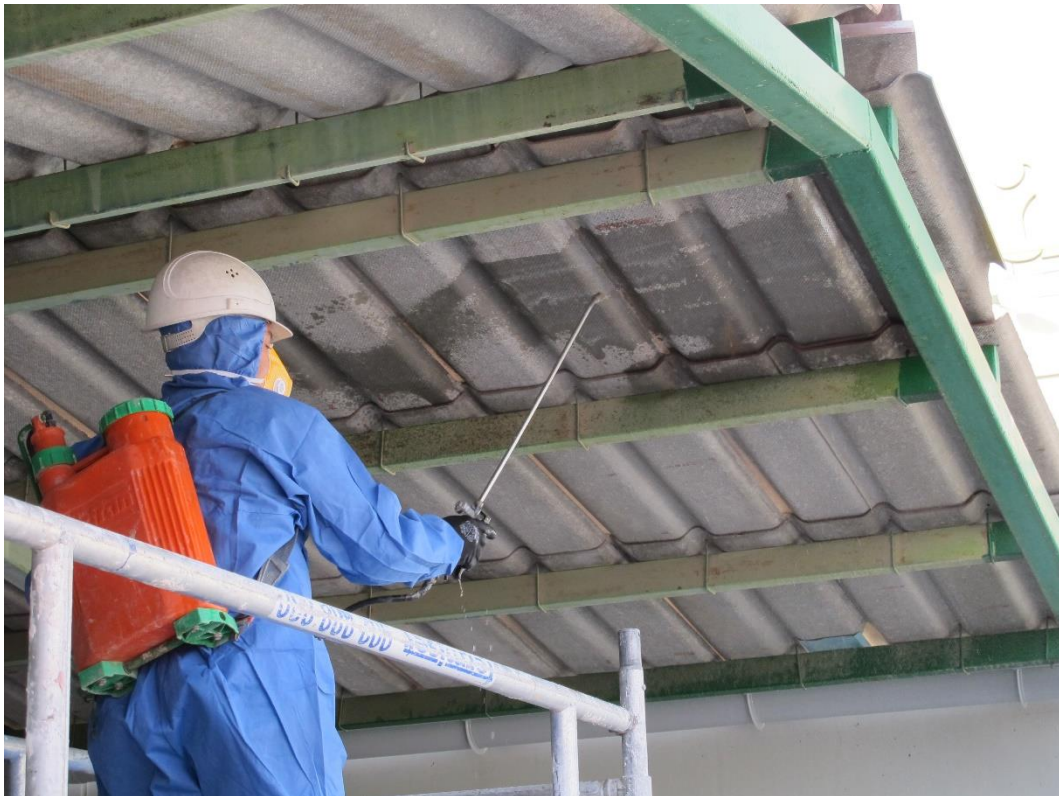
Figura 44. Encapsulado de las placas de fibrocemento. Fuente: Elaboración propia.
