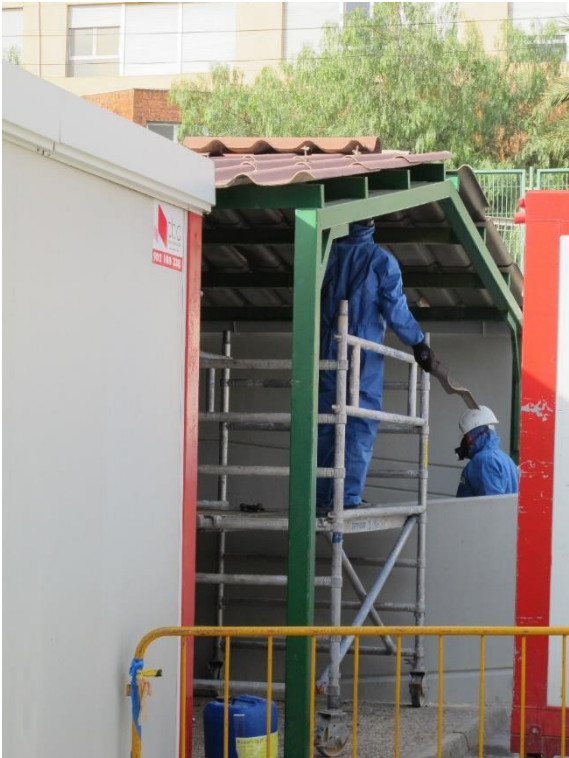
Figura 48. Desmontaje de la cubierta. Fuente: Elaboración propia
