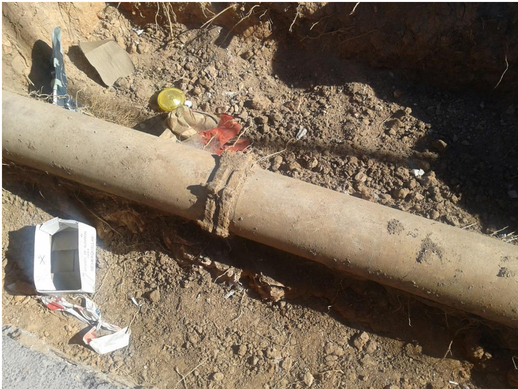
Figura 77. Tubería de fibrocemento. Fuente: Demoliciones D-Tres S.L.L
