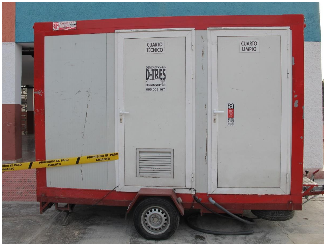
Figura 8. UMD, entrada por zona o cuarto limpio. Fuente: Elaboración propia.
