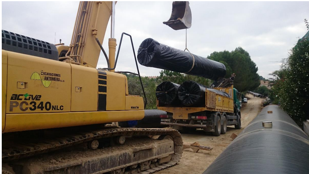
Figura 84. Carga de tuberías macroencapsuladas para transporte a zona de acopio.
