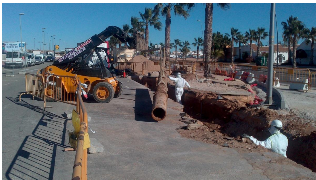
Figura 79. Desmontaje de tubería con maquinaria. Fuente: Demoliciones D-Tres S.L.L
