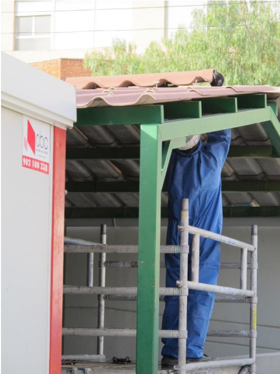
Figura 47. Desmontaje de la cubierta. Fuente: Elaboración propia
