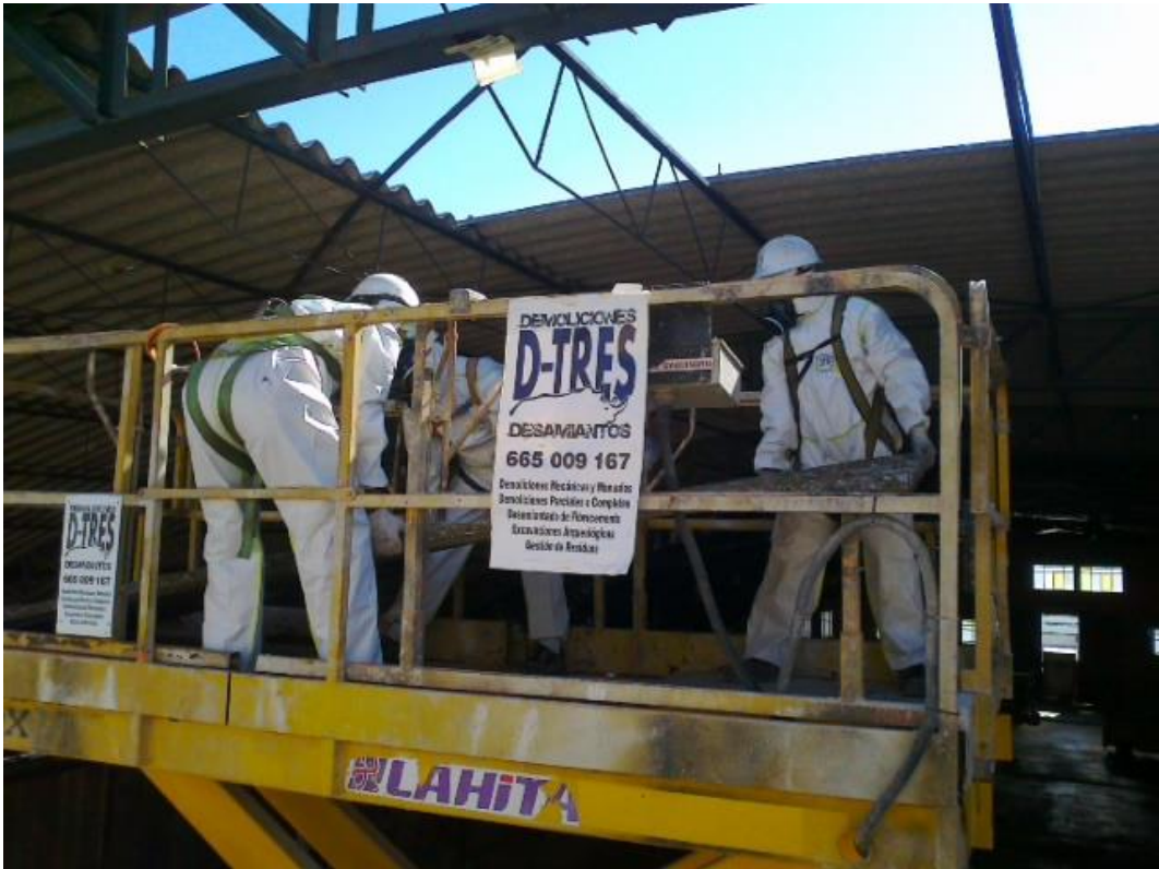
Figura 74. Desmontaje de cubierta de fibrocemento desde plataforma motorizada, acopio sobre plataforma.
