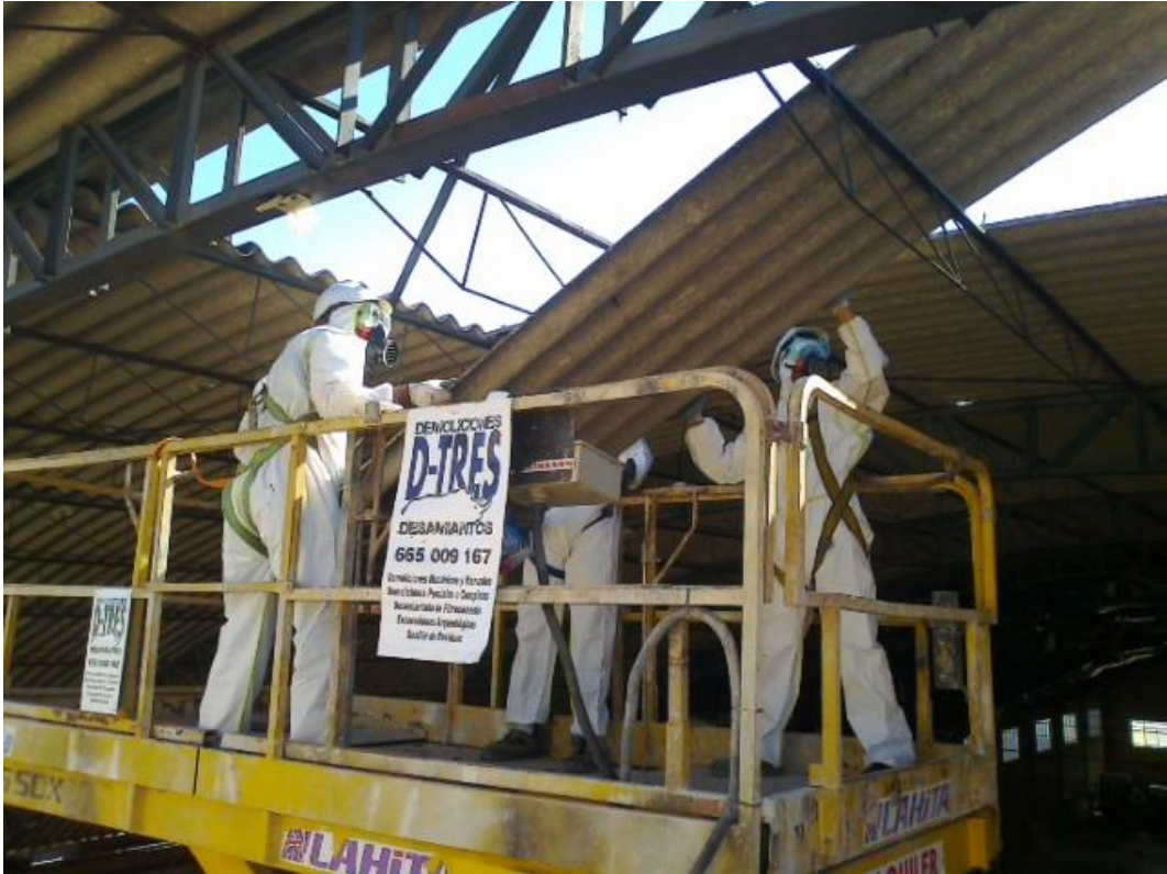
Figura 73. Desmontaje de cubierta de fibrocemento desde plataforma motorizada.
