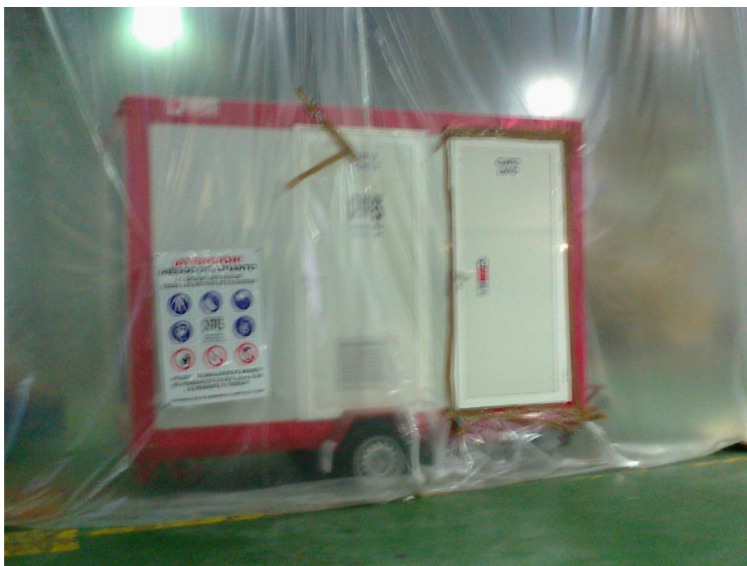
Figura 69. UMD, entrada a zona compartimentada. Fuente: Demoliciones D-Tres S.L.L.
