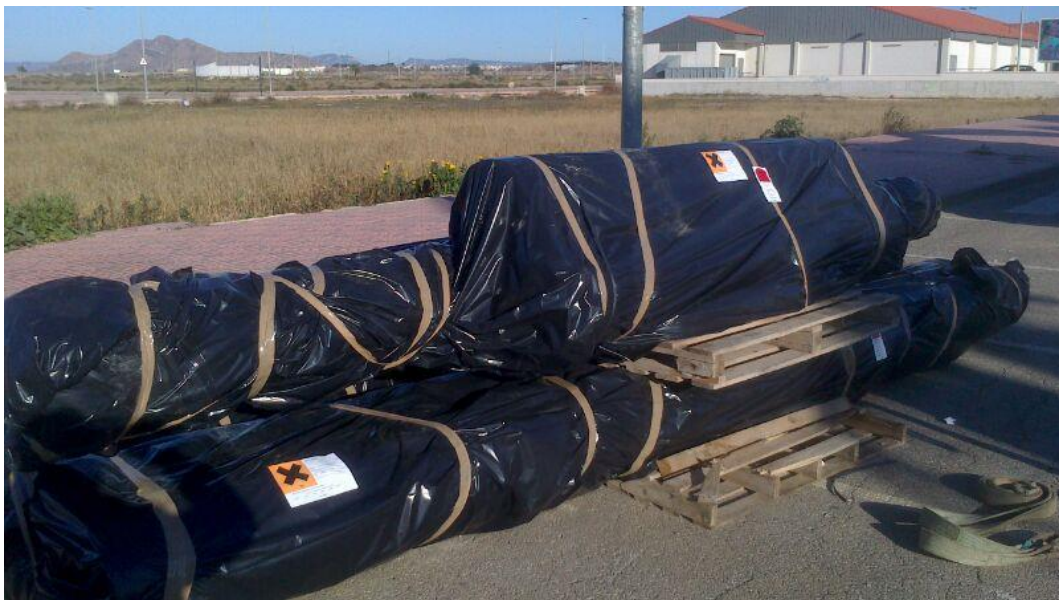
Figura 81. Tuberías de fibrocemento macroencapsuladas, paletizadas y etiquetadas.
