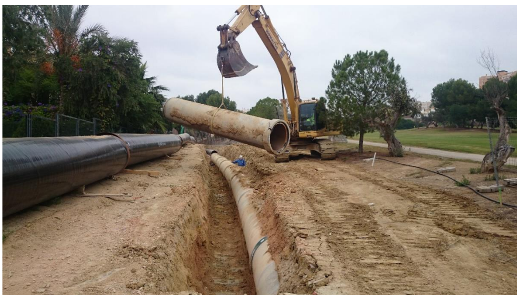
Figura 83. Desmontaje de tubería con maquinaria. Fuente: Demoliciones D-Tres S.L.L
