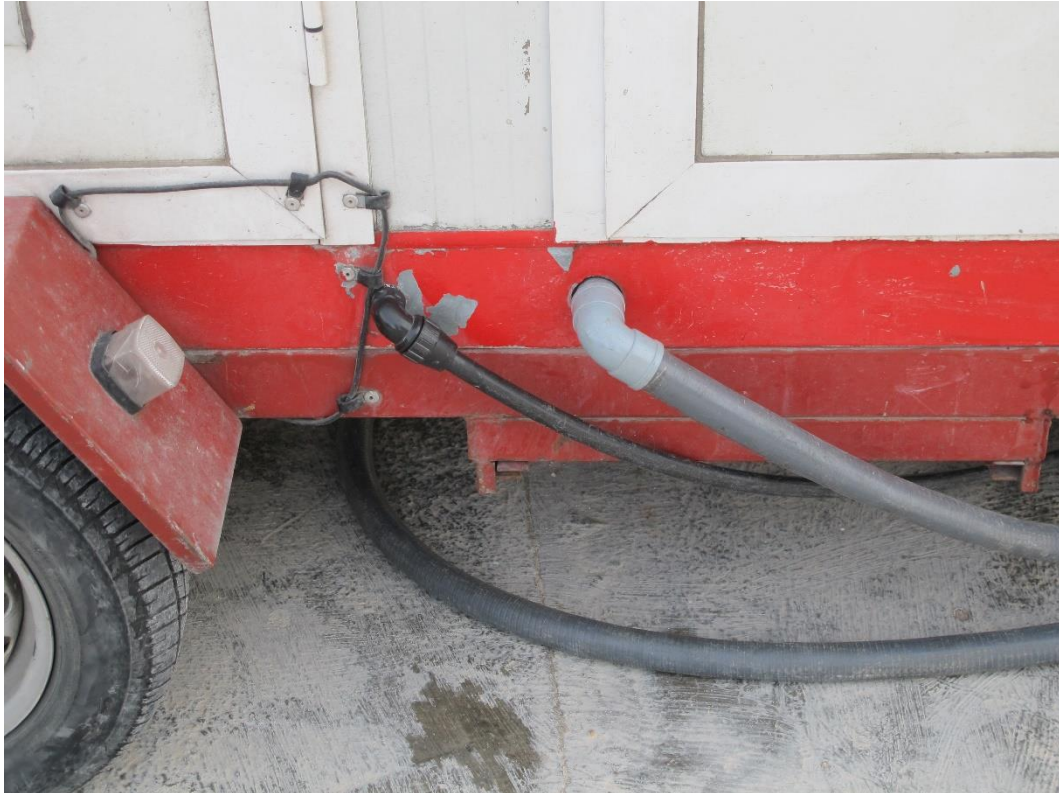
Figura 2. Conexiones de abastecimiento y desagüe de agua a la UMD. Fuente: Elaboración propia.
