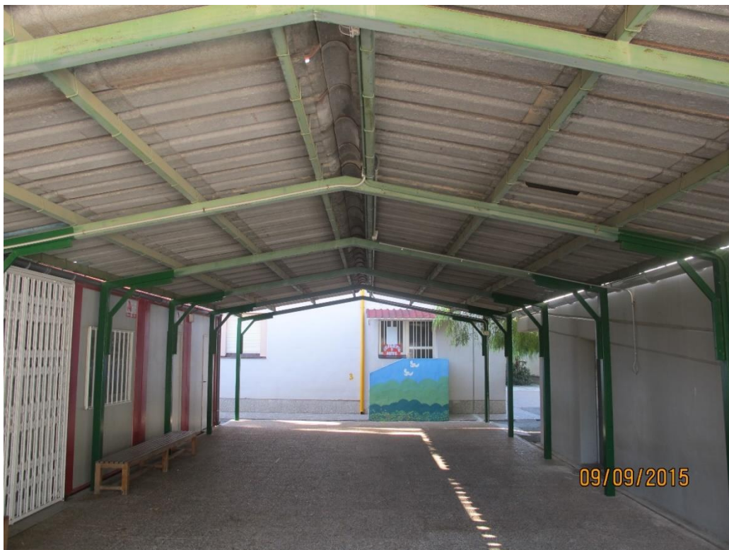
Figura 34. Cubierta de placas de fibrocemento en forma de cobertizo. Fuente: Gocoa. S.l.
