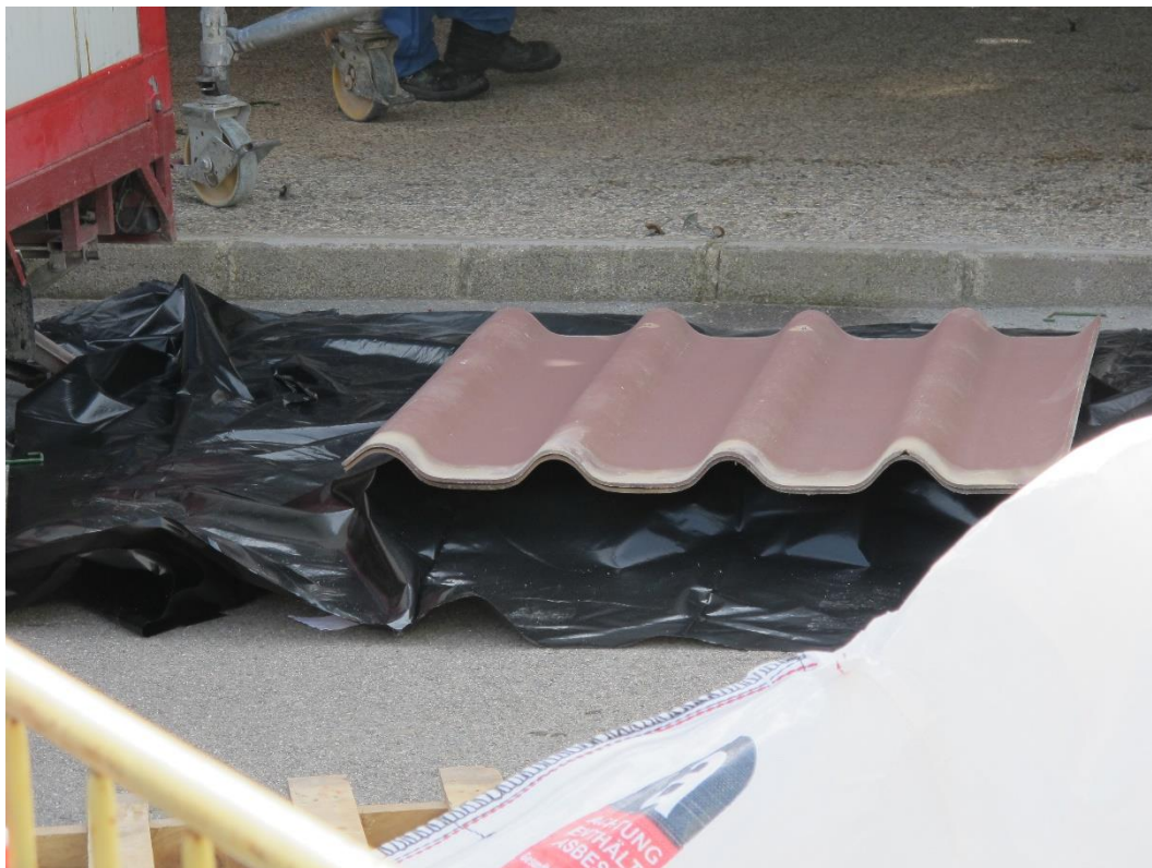
Figura 49. Acopio sobre lámina plástica. Fuente: Elaboración propia.
