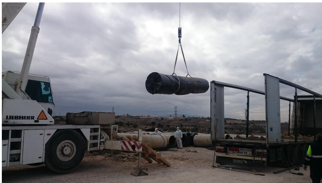
Figura 86. Carga de residuos en vehículo autorizado. Fuente: Demoliciones D-Tres S.L.L.
