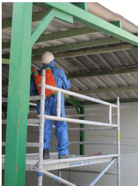
Figura 45. Encapsulado de las placas de fibrocemento. Fuente: Elaboración propia.
