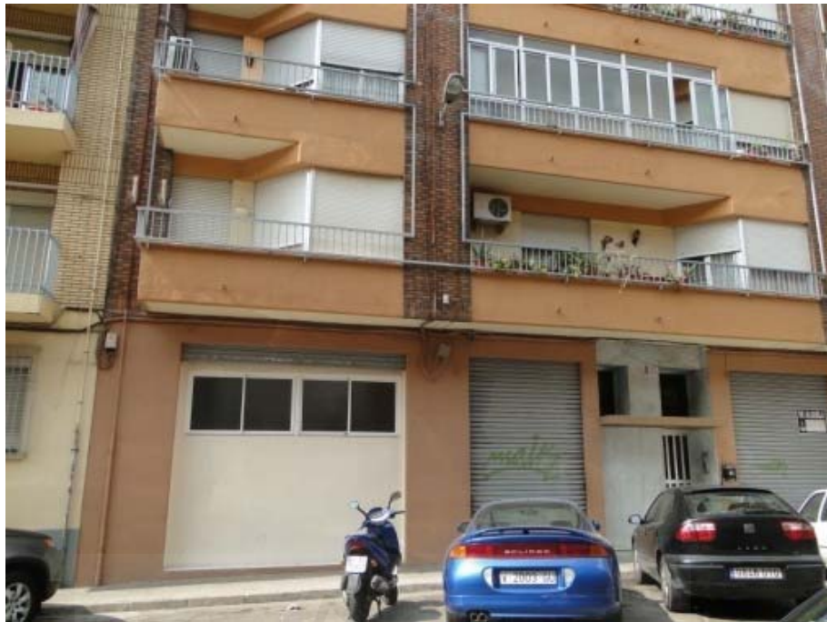
Ilustración 64. Fachada centro islámico de Torrent.
