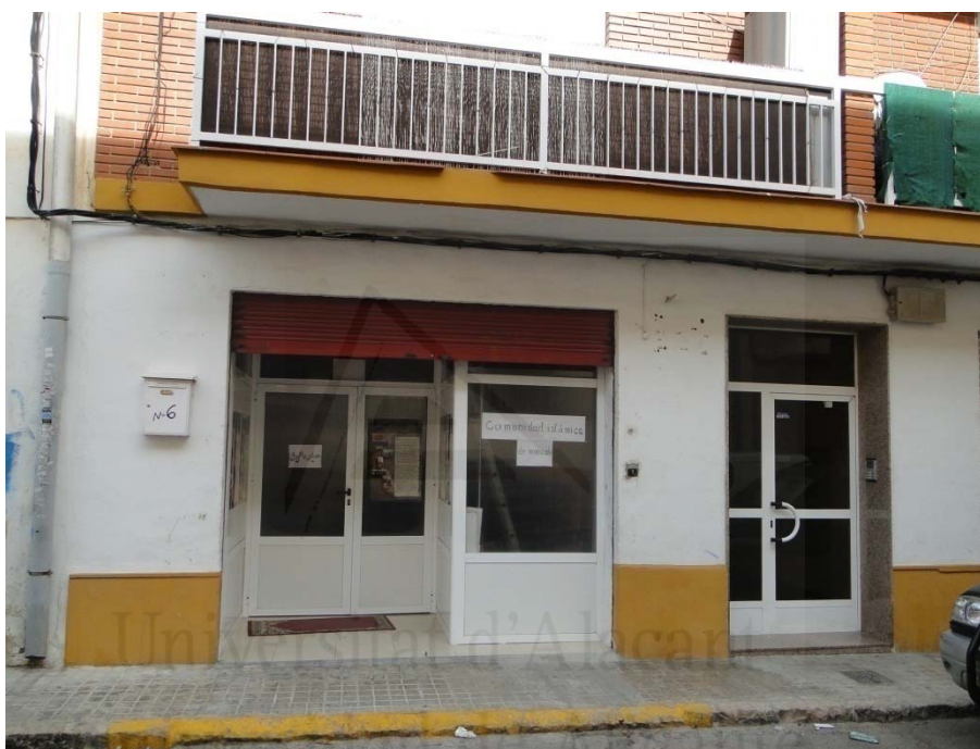
Ilustración 124. Fachada mezquita de Moncada, Valencia. Elaboración propia.
