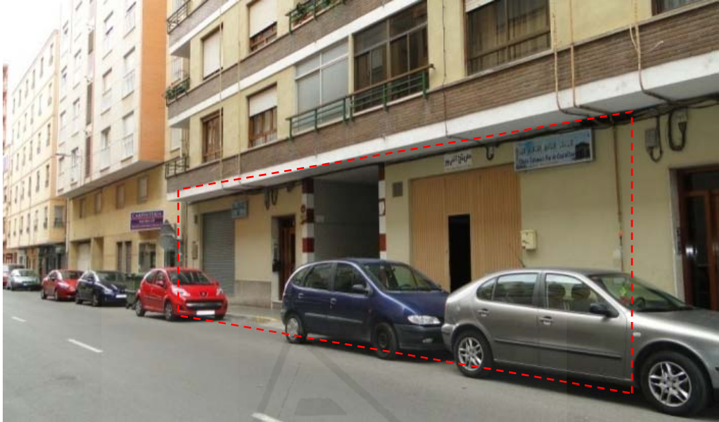
Ilustración 43. Local bajo: Castellón de la Plana.
