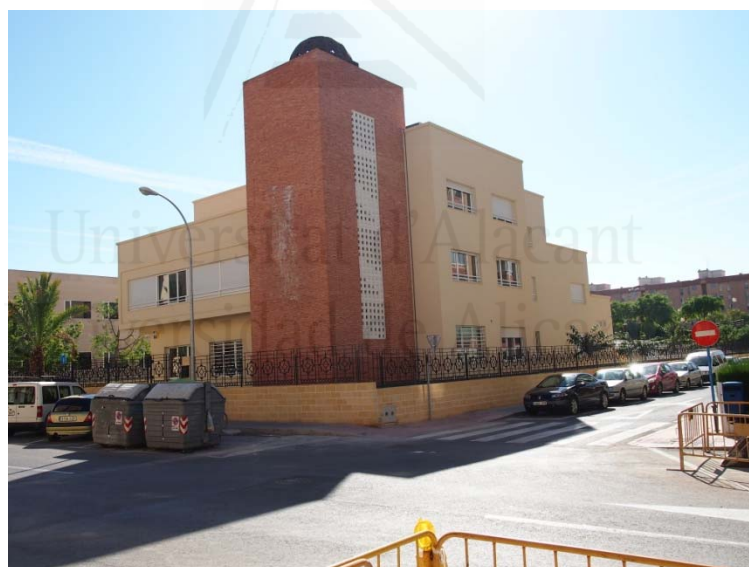
11. Edificios instalación única (Alicante, Virgen del Remedio)
