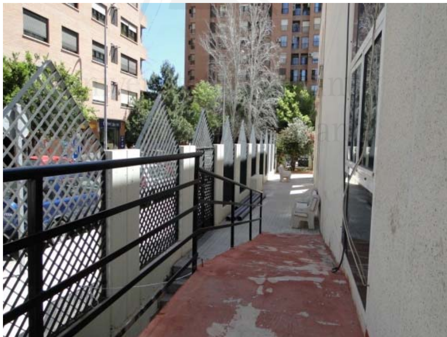
Ilustración 76. Foto de los espacios exteriores de la Gran mezquita de Valencia, salida de emergencia y entrada minusválidos. Elaboración propia.
