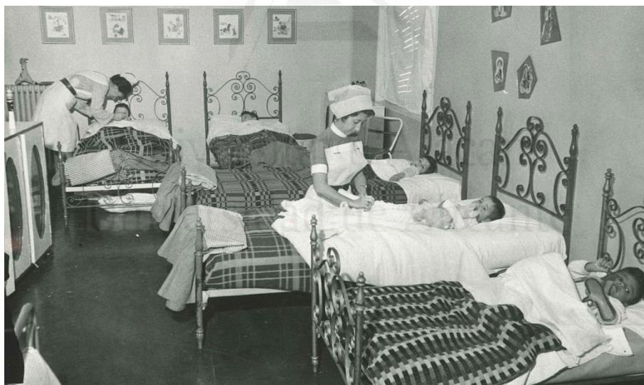
Figura 52: Dormitorio de la residencia.
