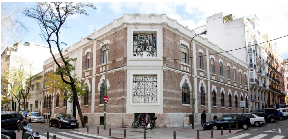
Figura 83: Fachada de la nueva sede de la Facultad.
