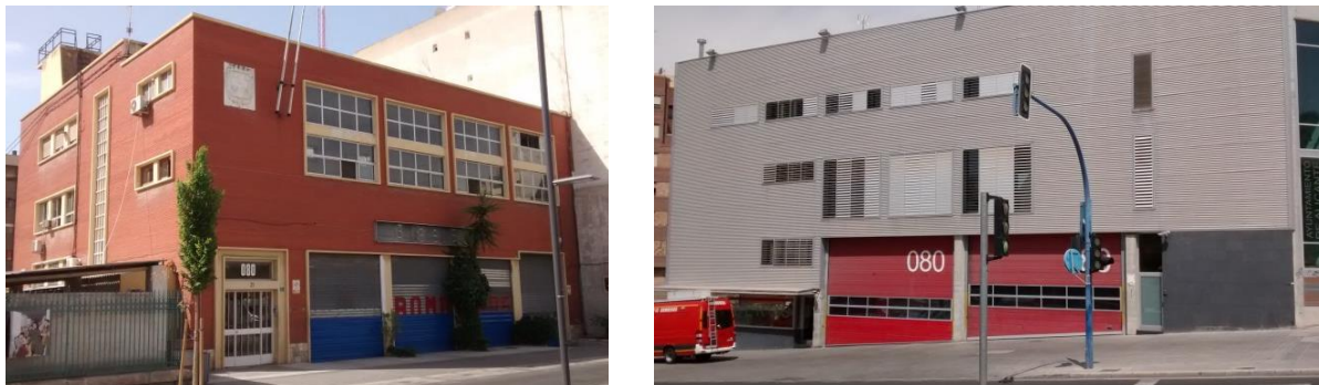
Figura 10. Antigua sede central y actual parque auxiliar del SPEIS
