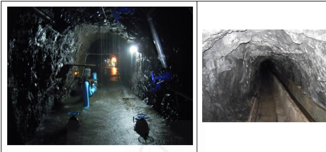
Figura 31. Drenaje de un frente saturado y transporte mediante canal o tubería en galerías de La Palma. Foto: Roberto Poncela.
