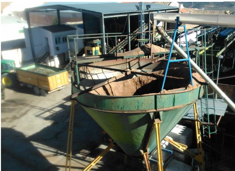
Deshuesadora y patio de descarga de la aceituna
