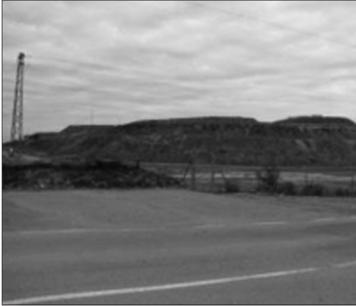
FIGURA 7. Emplazamiento en cumbres. Aznalcóllar (Sevilla)
