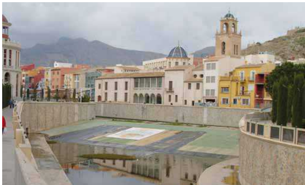
Figura 4. Canalización del río Segura a su paso por Orihuela tras las obras ejecutadas con posterioridad a la riada de 1987. La imagen muestra la panorámica tradicional de la ciudad que se ha visto notablemente alterada con los muros protectores del cauce y la ocultación de uno de los azudes medievales que abastecen la huerta (fotografía, G. Canales).
