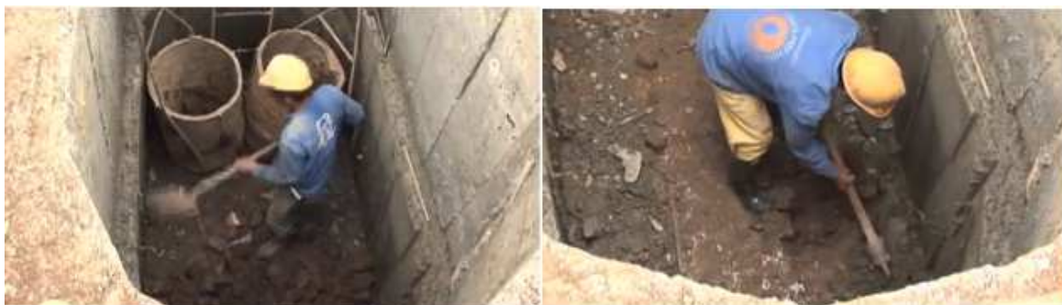
Figura 1. Excavación manual de un pozo de cimentación. Fuente: (Universidad politécnica de Valencia, S.F)
