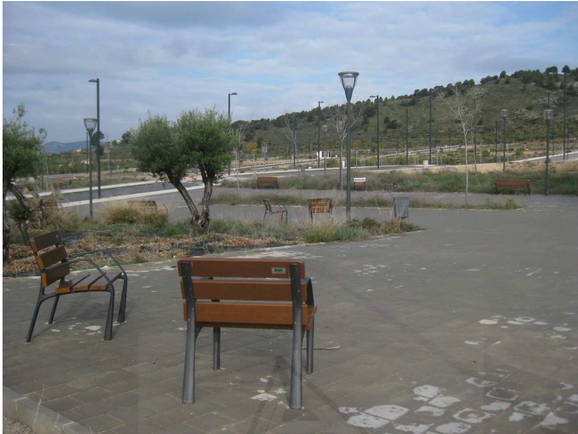
Figura 5.4 | Ibi: urbanización del sector residencial-dotacional Huerta del Carmen
