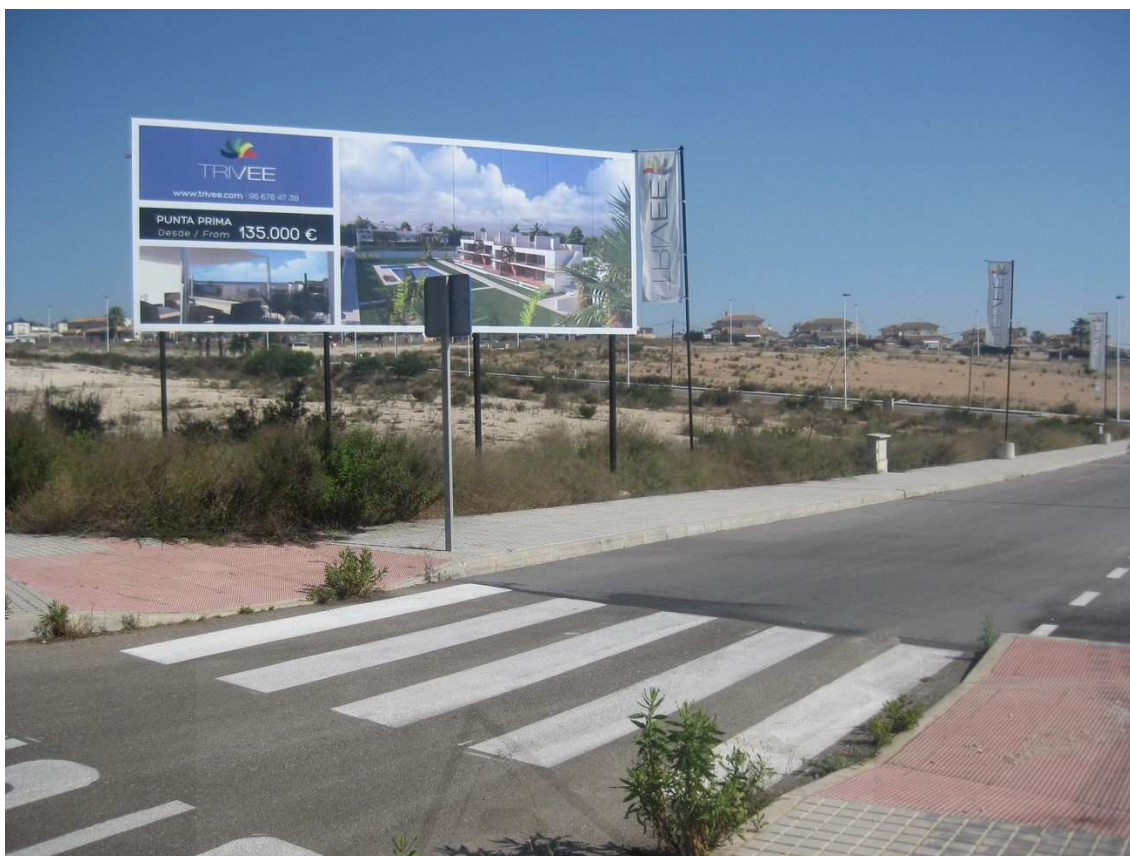
Figura 5.9 | Sector en vías de urbanización de La Ceñuela, Torrevieja Foto: Autor [24-05-2012].
