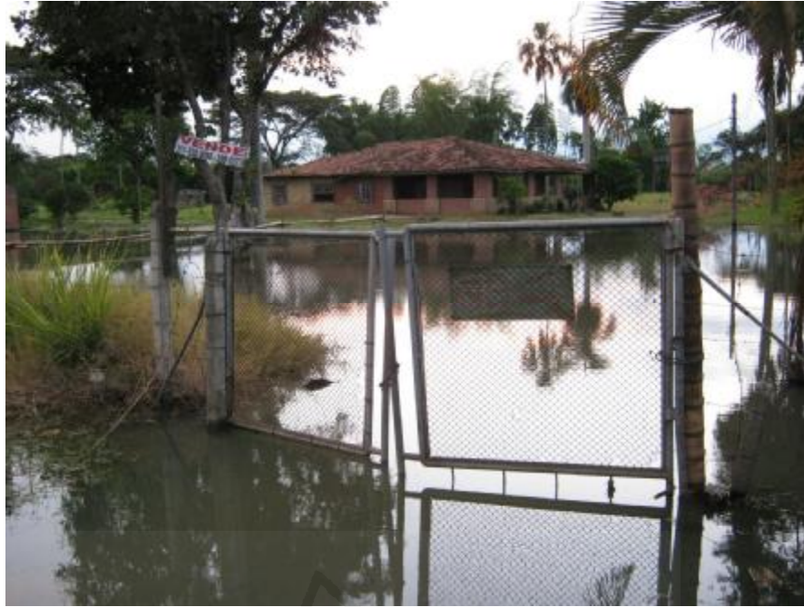
Figura 5.11 Las inundaciones del río Cauca sobre la vía que conduce de Cali a Candelaria. Foto del autor.
