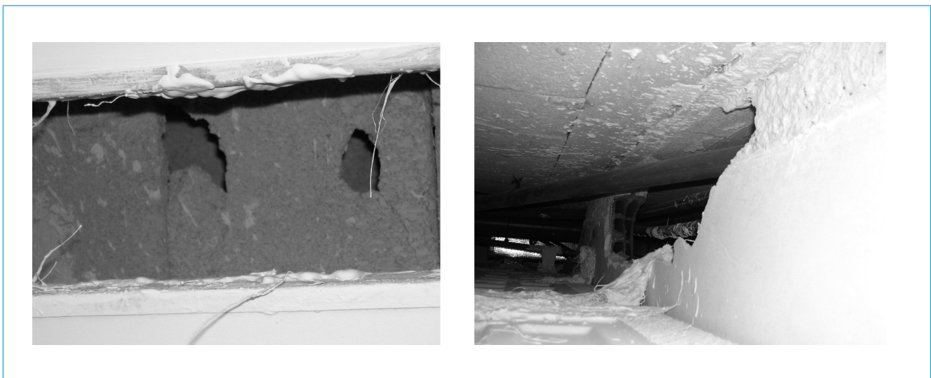
Figura 12. Fotografías de detalle de algunas obras
