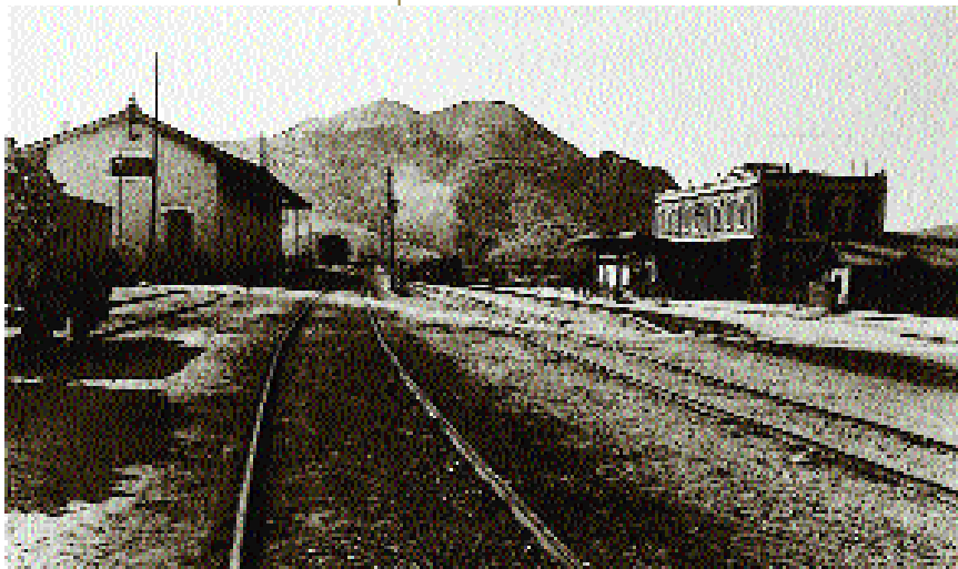
La nueva Estación del ferrocarril de Elda se terminó de construir durante la II República, pasando en 1933 a denominarse de Elda-Petrer a petición del Ayuntamiento de Petrer (Archivo EMIDESAS).
