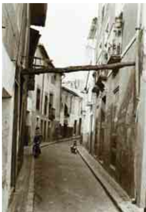
La entonces calle del general Solchaga mostraba el deterioro imparable que sufría el casco antiguo desde hacía varias décadas (CEFIRE).
