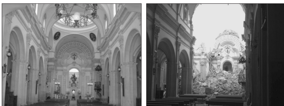
FIGURAS 10 y 11: Iglesia de Santiago fotografiada antes y después del terremoto. Se hundió la parte más rígida de la estructura de cubierta: el crucero con el cimborrio.
