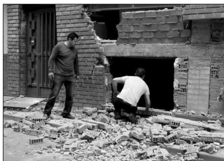
FIGURAS 24 y 25: Obsérvese en las plantas bajas el daño generalizado de los cerramientos, mientras las estructuras de los edificios permanecieron en pie.
