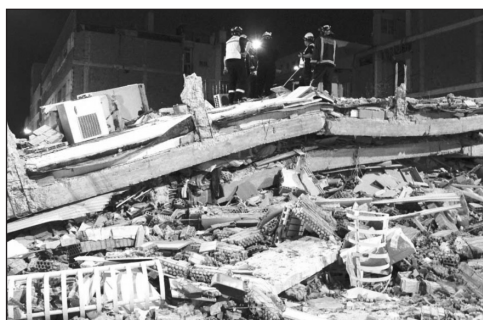
FIGURAS 22 y 23: Imágenes del edificio de la calle Infante Juan Manuel, nº 5, único edificio colapsado en su estructura, con el clásico apilado de forjados, que nunca hasta ahora se había visto en España. Muchas de las imágenes de televisión de los daños del terremoto, pertenecían al mismo edificio.
