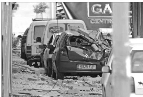
FIGURAS 26 y 27: Daños producidos en las aceras por el derrumbe generalizado de los antepechos de ladrillo de las cubiertas y de los balcones. Por este fenómeno se produjeron la mayor parte de las muertes, al caer los escombros sobre personas que salieron a la vía pública asustadas tras el primer terremoto.
