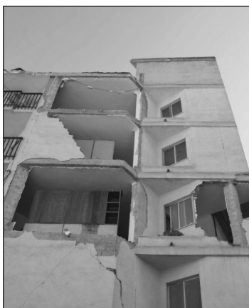
FIGURAS 28 y 29: A la izquierda, un ejemplo de edificio con cerramiento de ladrillo, sólo parcialmente apoyado en el borde del forjado. La estructura ha permanecido en pie cumpliendo las exigencias de la norma sísmica, pero los cerramientos se han derrumbado produciendo enormes daños materiales y riesgo de daños personales. A la derecha, un edificio en el que tanto estructura como cerramientos convencionales se comportaron correctamente, y lo que se derrumbó fue el «cerramiento provisional» con el que se tabicó los locales comerciales para su venta.
