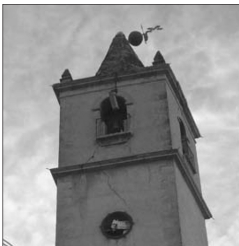
FIGURAS 14 y 15: Torre de la iglesia de Santiago y torre de la iglesia del Paso Azul, con daños por esfuerzo cortante en las fábricas, en las zonas más débiles (de huecos).
