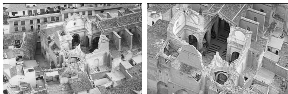
FIGURAS 8 y 9: Iglesia de Santiago cuyo crucero resultó completamente derrumbado por el sismo. Imágenes aéreas tras el terremoto.
