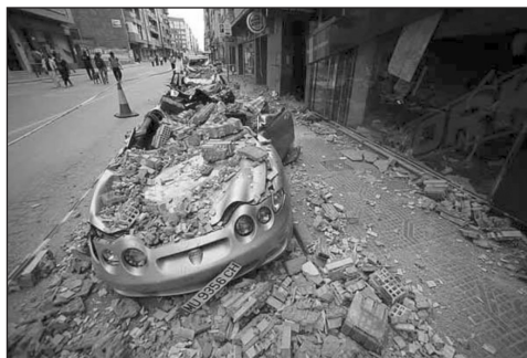
FIGURAS 26 y 27: Daños producidos en las aceras por el derrumbe generalizado de los antepechos de ladrillo de las cubiertas y de los balcones. Por este fenómeno se produjeron la mayor parte de las muertes, al caer los escombros sobre personas que salieron a la vía pública asustadas tras el primer terremoto.
