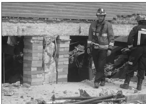
FIGURAS 20 y 21: A la izquierda, pilar corto, destruido por el sismo; este tipo de pilares, por su imposibilidad de oscilar, es el que resulta más afectado. A la derecha, rotura por la cabeza de un pilar, del edificio que colapsó completamente.
