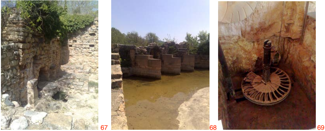
67 y 68: molinos harineros de cubo de la Vila, en el municipio de Montblanc. 69 rodezno de madera.
