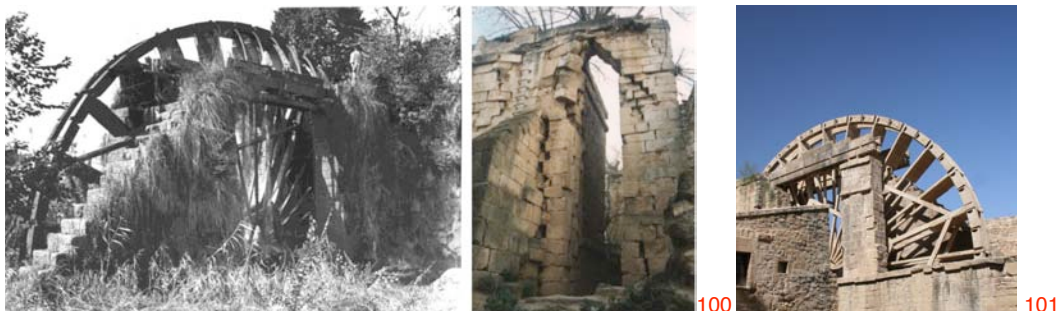
100 estado inicial antes de la rehabilitación. 101 estado actual de la noria
