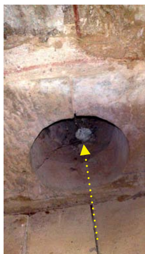
78 vista interior del aljibe abovedado. 79 salida del agua del aljibe en la parte inferior del mismo
