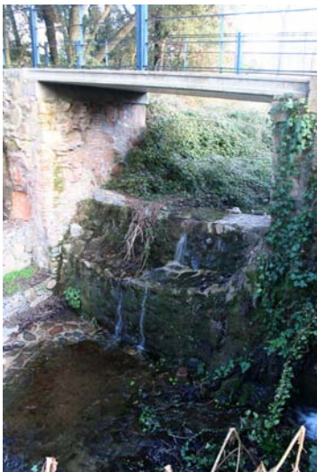
Restos del azud del Pruners, próximos al monasterio.
