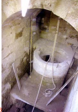
106 interior del molino. 107 cubete de sillería del molino de regolfo a la salida del cárcavo. 108 rodezno de madera.
