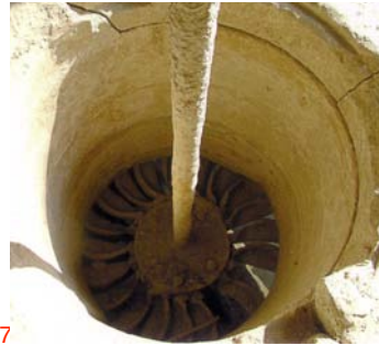
106 interior del molino. 107 cubete de sillería del molino de regolfo a la salida del cárcavo. 108 rodezno de madera.
