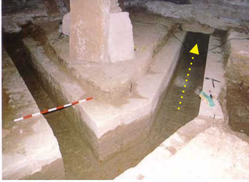
Atarjea general discurriendo bajo el scriptorium hacia el calefactorio y la cocina.
