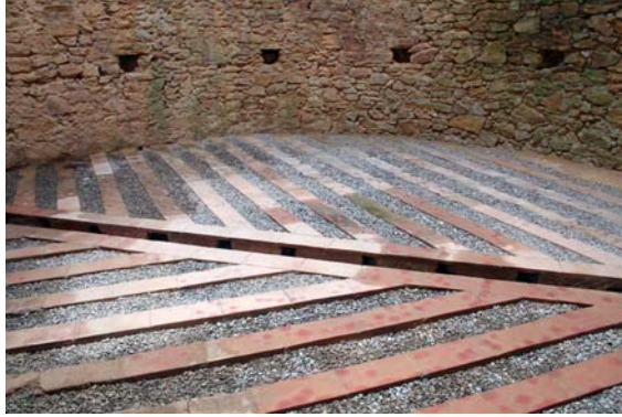
153 interior del pozo de hielo. 154 sistema de drenaje en la base del pozo mediante grava y canalillos.
