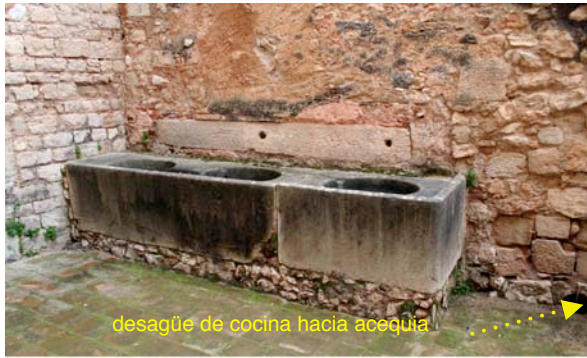
172 bancada en cocina formada por dos piezas de piedra sobre mampostería.
