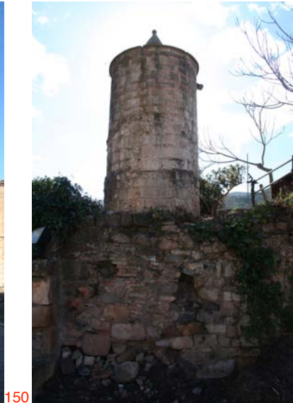
Torre de les aigües y conducto de abastecimiento sobre muro.
