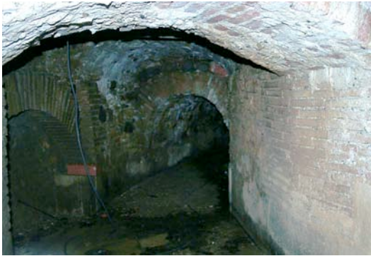
sección de galería subterránea construida mediante ladrillo de tejar, sillería y mortero de cal hidráulica
