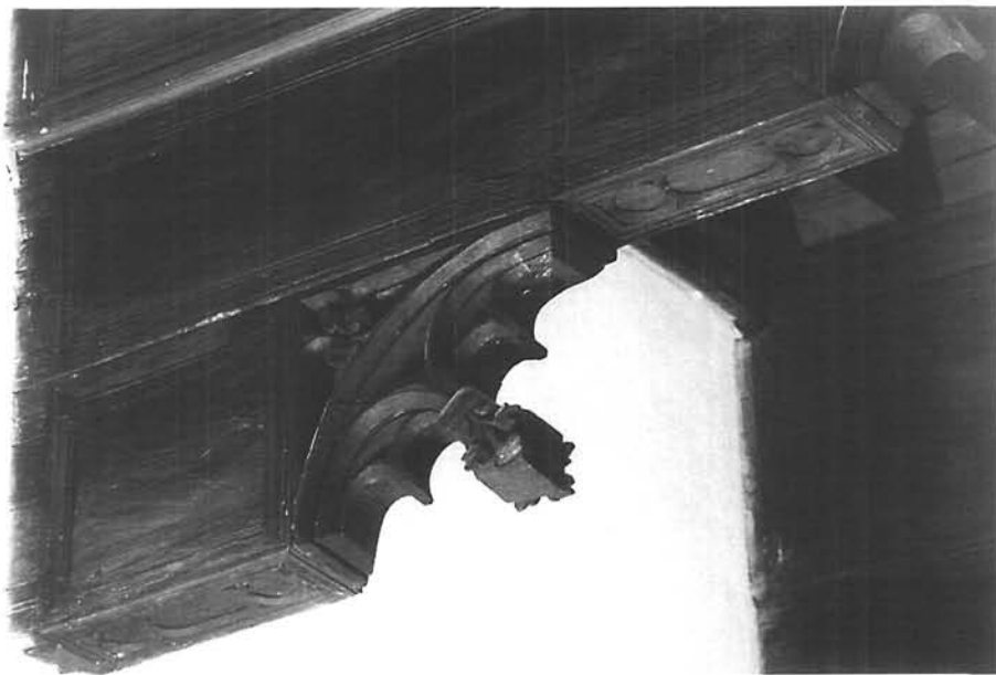
Fig. 8. Detalle de la techumbre del Ayuntamiento de Cantavieja (Teruel).
