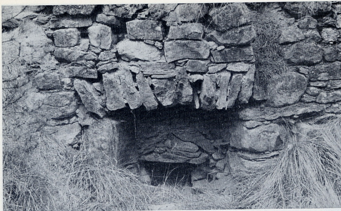
FIG. 2. — Detall d'una de les boques d'alimentació del forn existent en el Pla de la Pinassa.
