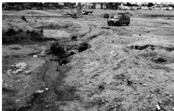
Figura 19. Estado del área de excavación del foso en noviembre de 1999
