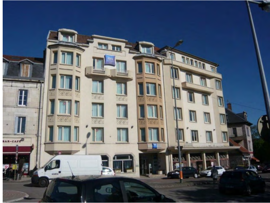
Fig. 10.4. Hotel junto a la estación de de ferrocarril convencional de Besançon.
