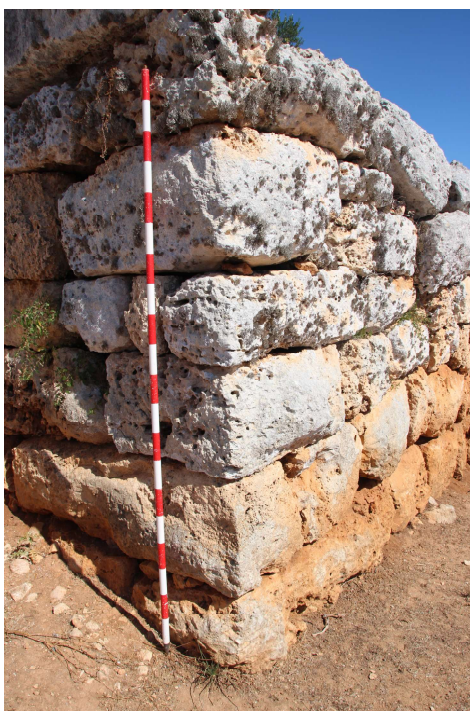
Fig. 3. Detalle de los sillares almohadillados y la anathyrosis del bastión SE de Son Catlar.
