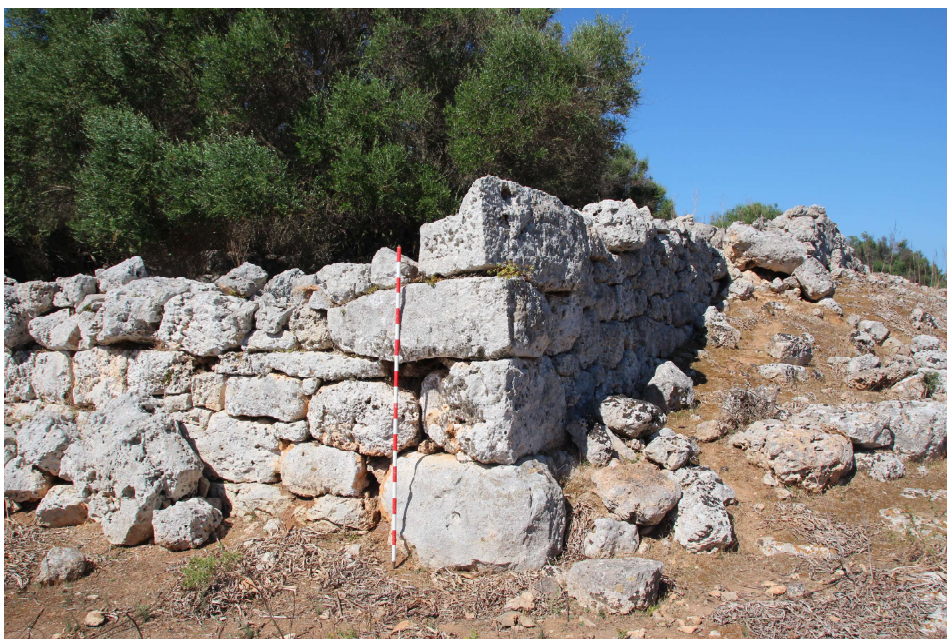
Fig. 10. Esquina SE de Son Catlar. Aparejo a “soga y tizón” y sillares almohadillados.
