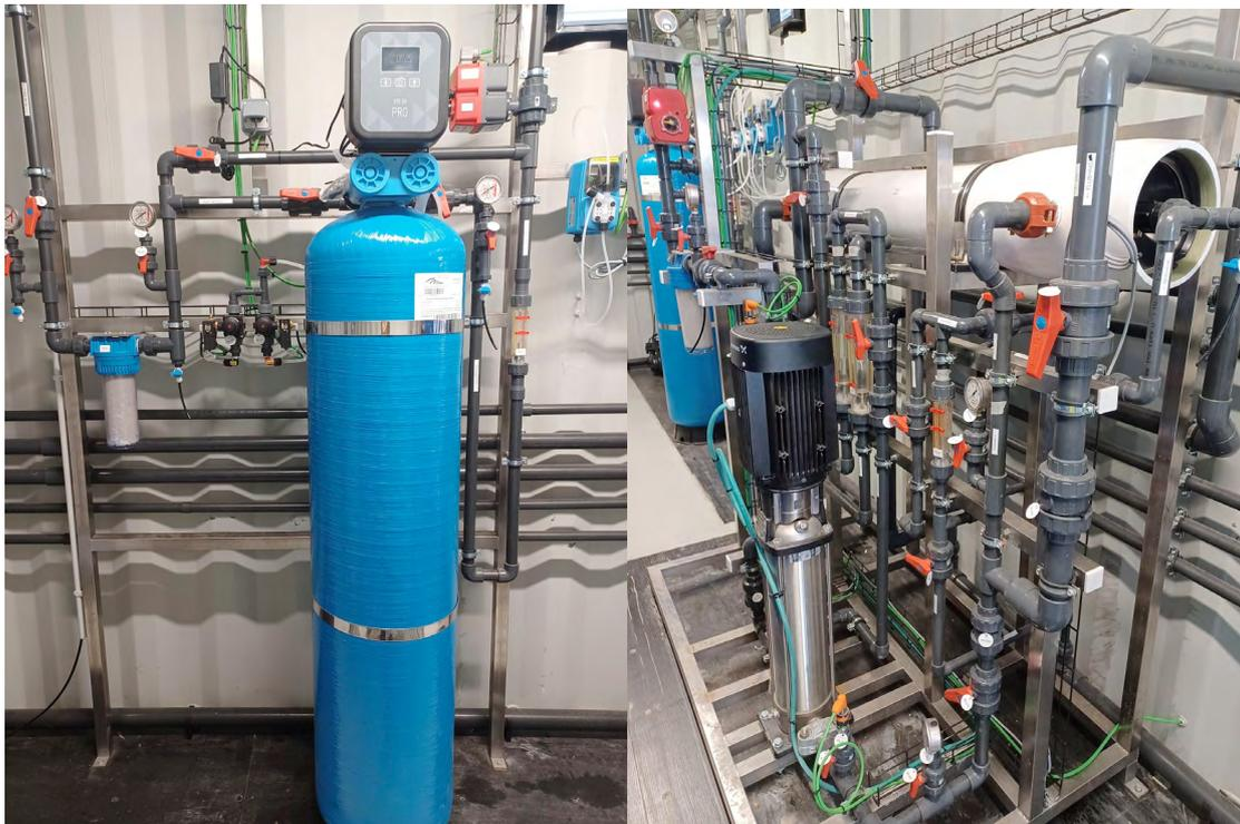
Figura 5. A. Izquierda: descalcificadora (resinas). 5.A. Derecha: membranas de nanofiltración.
