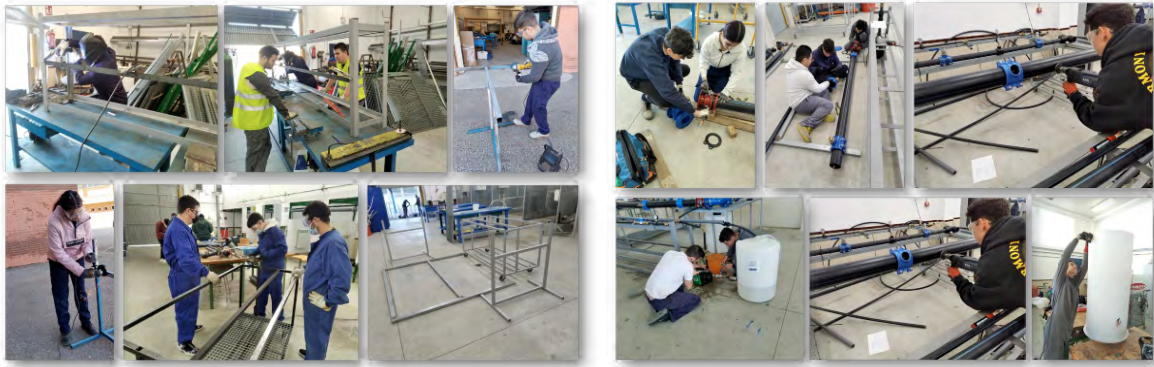
Figura 1. Prácticas de construcción y montaje del banco de ensayos.
