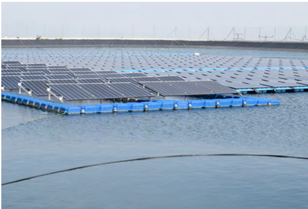
Figura 3. Placas flotantes en el embalse de La Beatas de la C.R. de Puerto Lumbreras. Fuente: elaboración propia.
