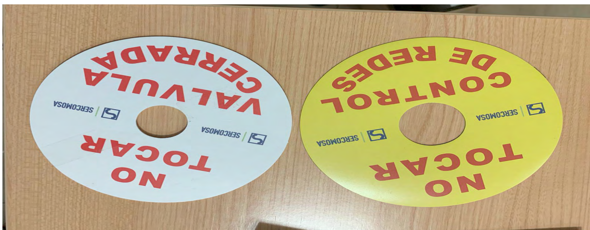
Figura 8. Señalización de válvula cerrada temporalmente y cerrada habitualmente.
