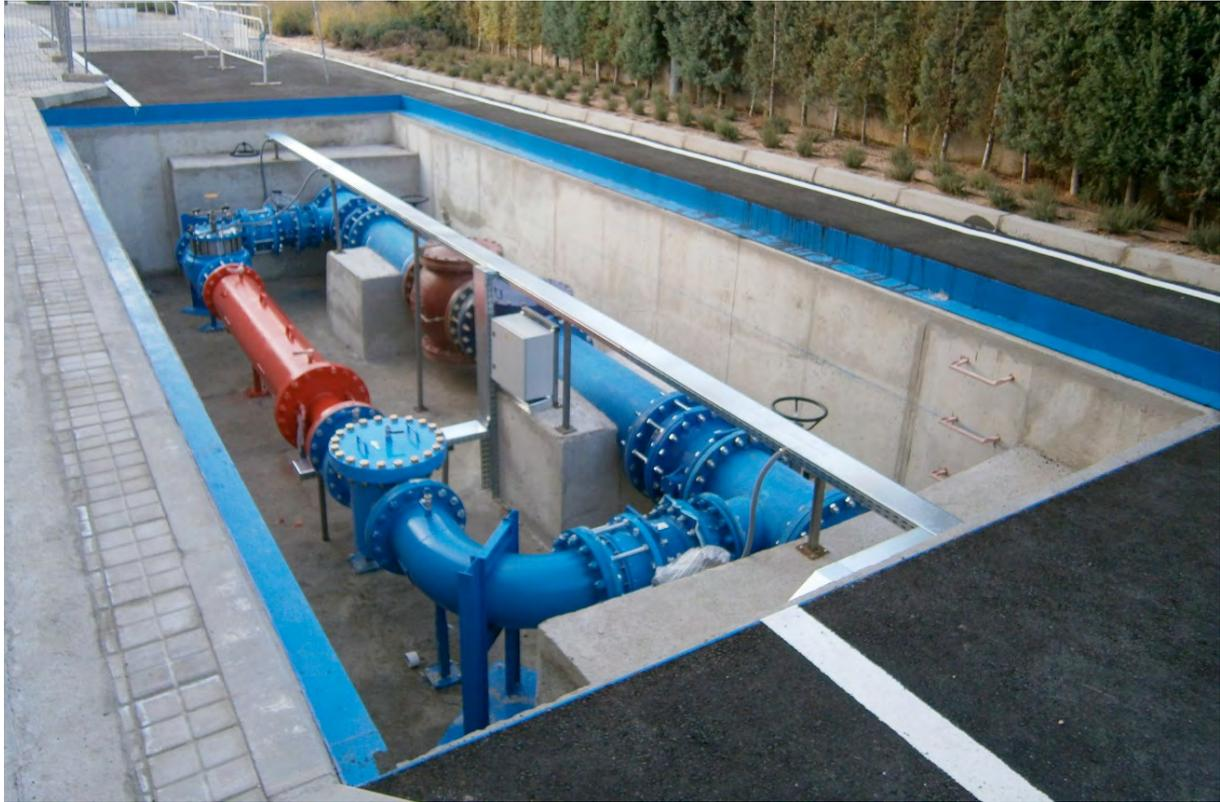
Figura 9. Instalación de microturbina a la entrada de la ETAP de Griñón.
