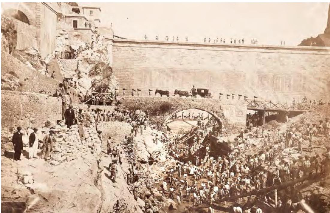
Figura 2. Construcción del Pontón de la Oliva. Fuente: Canal de Isabel II (2021).
