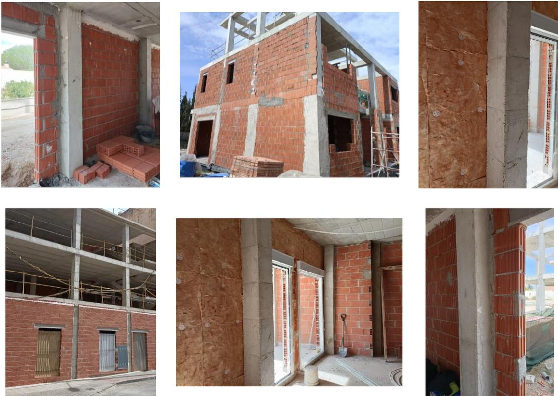
Figura 2. Ejemplos de puente térmico de pilares integrados en fachada. Fuente: elaboración propia.
