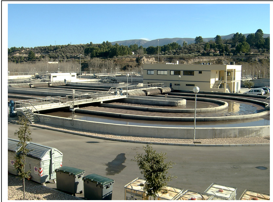
Figura 3. Foto de la depuradora Font de la Pedra en Muro.
