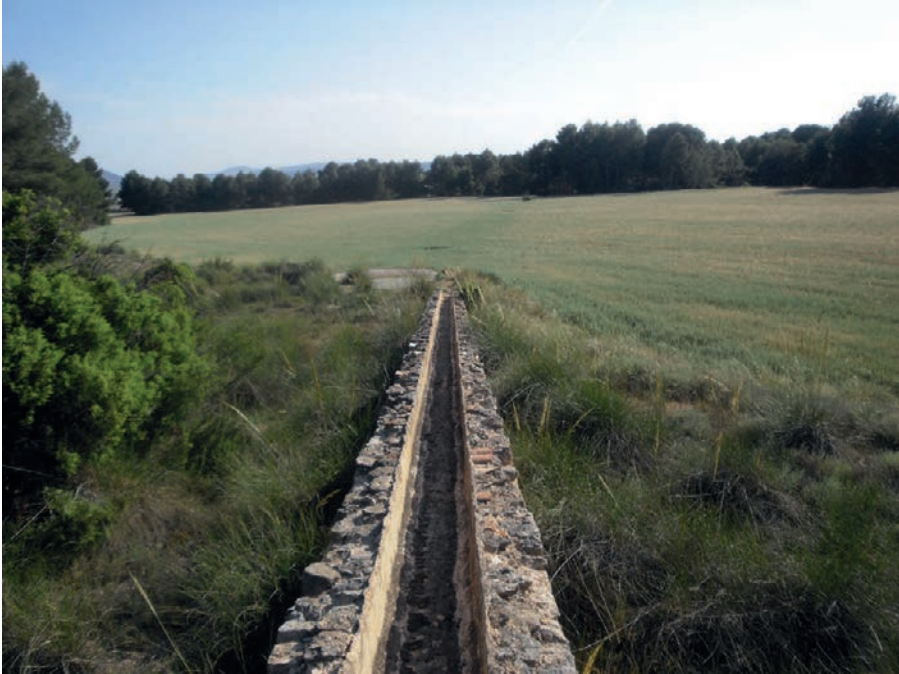
Figura 3. Vista de un tramo de la Acequia Antigua. Foto: Autores.
