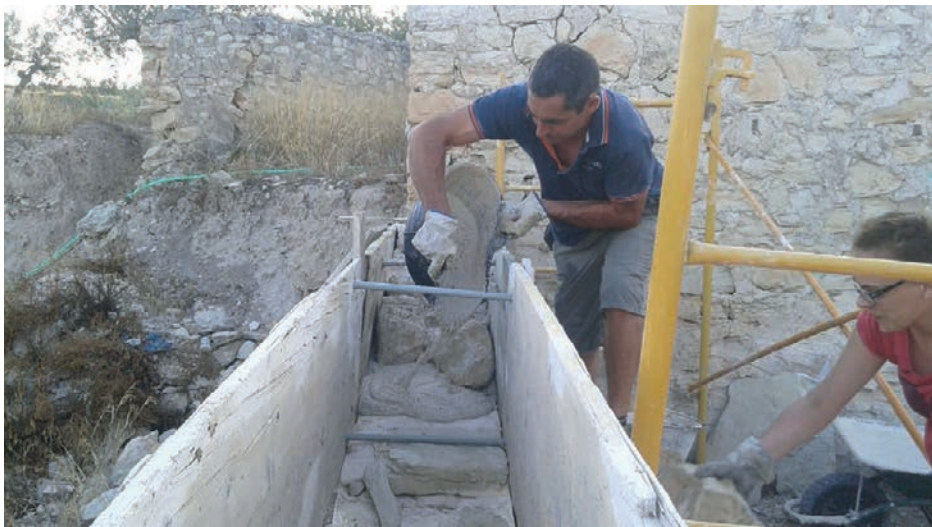
Figura 6. Encofrado con mortero de cal tipo tapia.
