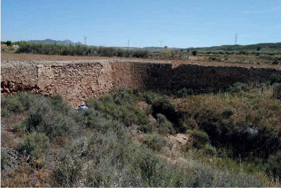
Figura 6. Bocamina del minado de «Los Manadores» – Fuente del Pino.
