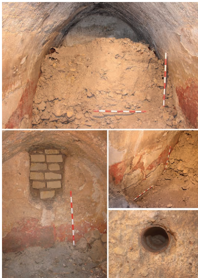
Figura 8. Vistas interiores del aljibe III con detalle del relleno y de uno de los atanores (Archivo Museo Dámaso Navarro).
