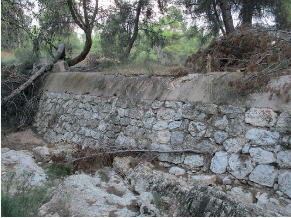
Figura 8. Dique de contención en el cauce de la Rambla. Foto: Autores.
