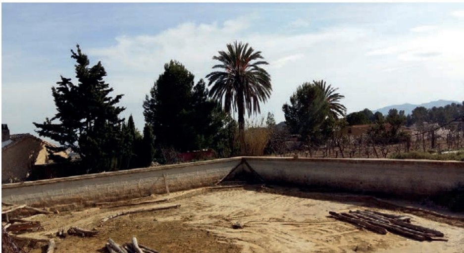
Figura 4. Balsa de descarga destinada a pozas (en obras). Fondo de Asoc. Xinosa.
