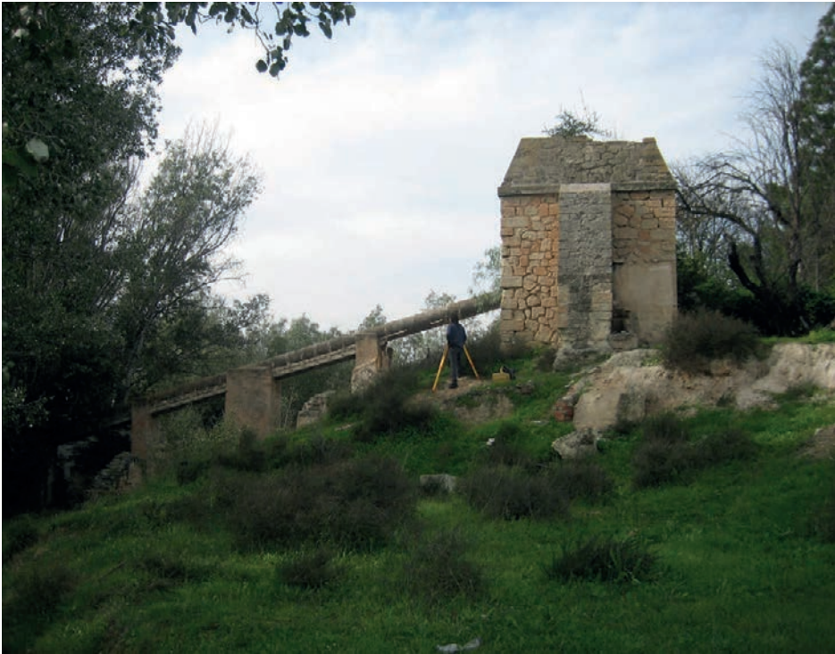
Figura 5. Fábrica del Chorrillo. Toma de datos.
