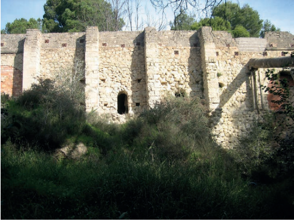
Figura 6. Contrafuertes que sustentan parte de la acequia en su tramo final antes del salto (Fábrica de Luz del Chorrillo).
