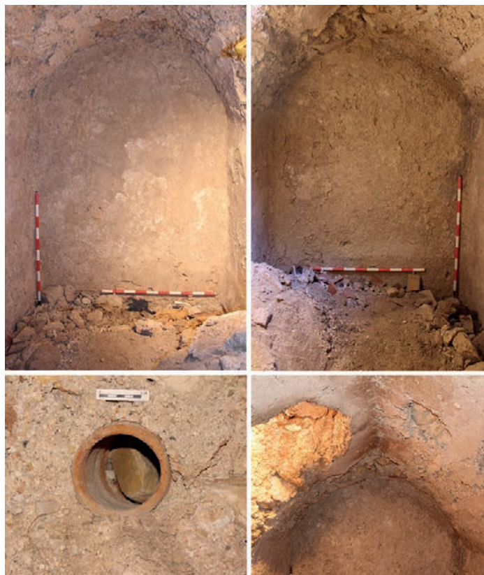
Figura 6. Vistas interiores del aljibe II con detalle de sus paredes, bóveda apuntada y el borde del atañor (Archivo Museo Dámaso Navarro).
