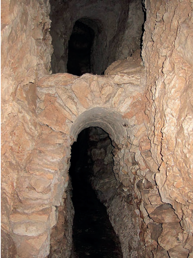
Figura 6. Superposición de arcos en el interior del Minado Nuevo. Foto: Autores.
