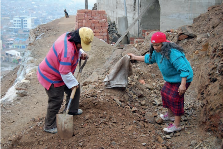
Figura 5. Dos pobladoras del cerro participan en el proyecto de alcantarillado y agua potable.
