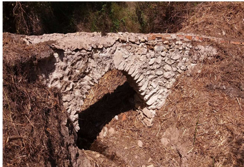
Figure 10. Aqueduct at Sa Falzia (Tàrbena).
