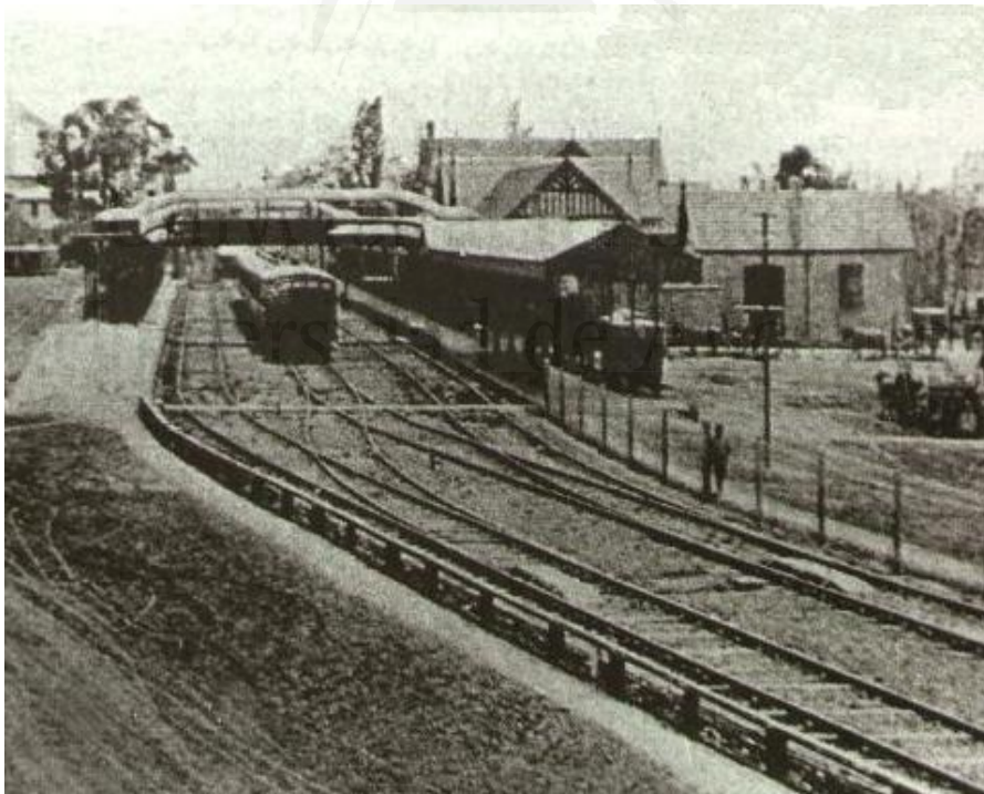
Figura 26. Estación de ferrocarril de Tigre.
