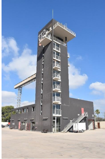
Ilustración 17 - Torre de bomberos de Alicante
