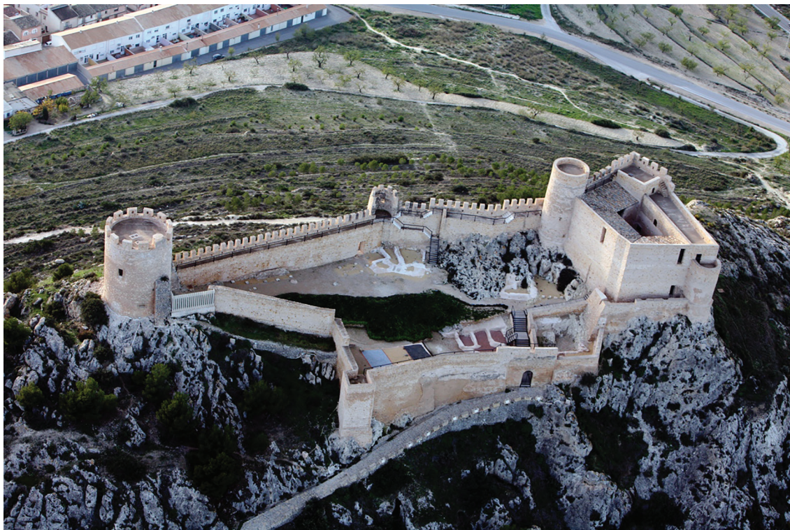
Fig 3. Vista actual del Castell de Castalla. De izquierda a derecha: Torre Grossa, Pati d'Armes y Palau. Autor: Andrés Ruiz Sánchez
