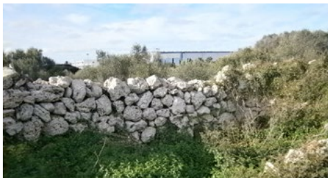
Figura 3.11.6. A l'esquerra, parament amb tècnica de marger que es troba per l'interior al punt on es localitza la «torre» sud, des de l'est, i a la dreta, mur de pedra seca que lliga la torre amb la resta del marge, que cobreix grans blocs (font: autor)
