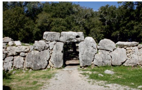
Figura 3.6.2. A l'esquerra, fotografia històrica del portal sud-est, on s'observa a la filada superior esquerra un bloc actualment desaparegut (font: postal, s/a), i a la dreta, fotografia actual, on s'observa pèrdua del tercer bloc de la filada superior a l'esquerra de l'entrada (font: autor)
