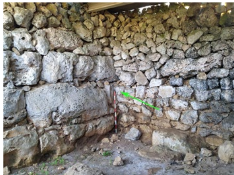
Figura 3.1.2. A dalt, parament extern de la murada, amb filades regulars i algun gran bloc, damunt la qual s'observen paraments d'època moderna o contemporània; a baix a l'esquerra, parament intern de la murada, i, a baix a la dreta, parament intern de la murada adossat al parament extern del clos del complex de la Talaia Joana (fletxa en verd), visible a l'interior dels estadossos. A mitja alçada s'observa la superposició d'un mur de pedra seca de pedra més petita (font: autor)
