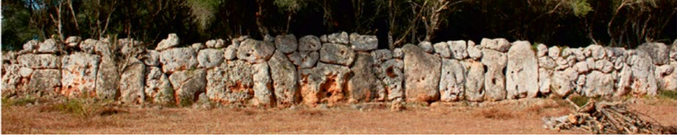
Figura 3.4.2. Fotografia de l'exterior de la murada sud-oest (font: autors)
