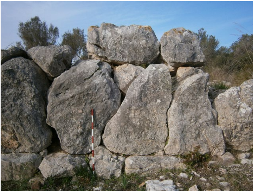
Figura 3.3.3. Parament extern poligonal conservat a l'est (font: autors)
