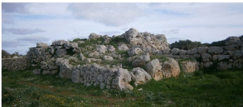
Figura 3.11.3. A dalt, imatge del parament extern de la casa 5 i de la sala hipòstila adjacent, i a baix, vista de l'angle sud-oest de la torre nord, amb el talaiot al fons (font: autor)
