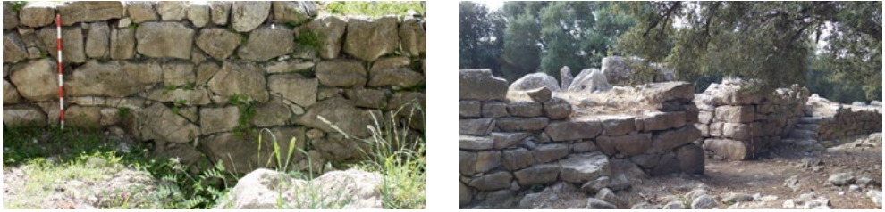
Figura 3.6.3. A l'esquerra, parament interior, i, a la dreta, escales al sud del portal sud-est (font: autor)
