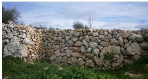
Figura 3.11.6. A l'esquerra, parament amb tècnica de marger que es troba per l'interior al punt on es localitza la «torre» sud, des de l'est, i a la dreta, mur de pedra seca que lliga la torre amb la resta del marge, que cobreix grans blocs (font: autor)
