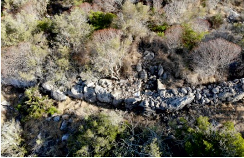
Figura 3.12.4. Vista aèria del portal sud (font: autors i Pedro Calzado)
