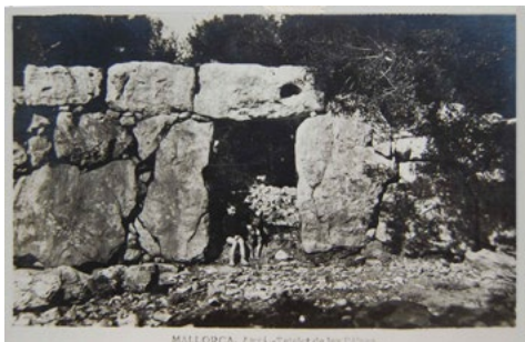
Figura 3.6.2. A l'esquerra, fotografia històrica del portal sud-est, on s'observa a la filada superior esquerra un bloc actualment desaparegut (font: postal, s/a), i a la dreta, fotografia actual, on s'observa pèrdua del tercer bloc de la filada superior a l'esquerra de l'entrada (font: autor)
