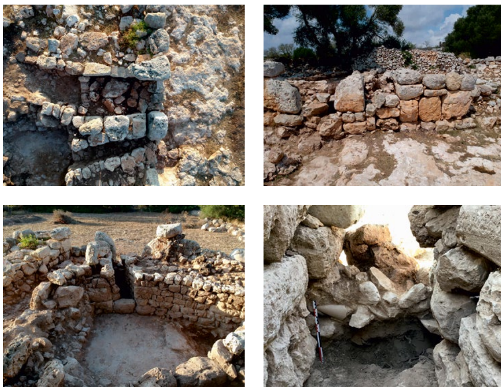
Figura 3.9.5. A dalt a l'esquerra, fotografia zenital de P3, on s'observa els paraments intern i extern del cegament, amb un potent nivell de reble de pedres a l'interior i els dos brancals. A la part inferior es veu com el brancal oest s'aprofita com a mur del passadís (E11) i com el parament intern de M2 s'adapta també a aquest passadís. A dalt a la dreta, vista de l'exterior de P3. Al centre a l'esquerra, fotografia des de l'interior del parament intern de M2 des de E10, amb l'accés al passadís i els brancals de P3. Al centre a la dreta, imatge del sediment adossat al cegament del passadís amb materials amfòrics del s. II arq BC (font: autors)
