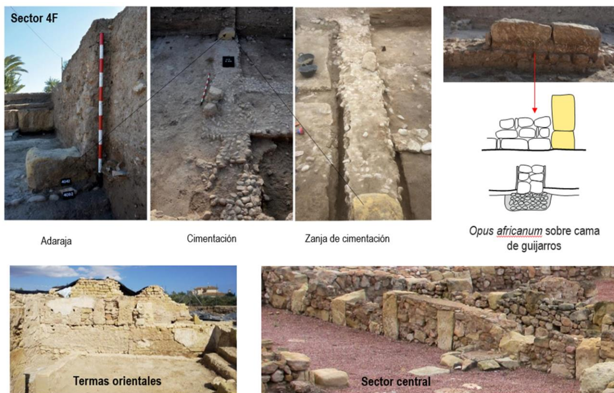
Fig. 105. Varias imágenes en las que podemos ver la “forma” de construir durante el periodo tardoantiguo en Ilici, con las características fosas de fundación y cimentaciones de guijarros sobre las que se alzaban muros de opus africanum .
