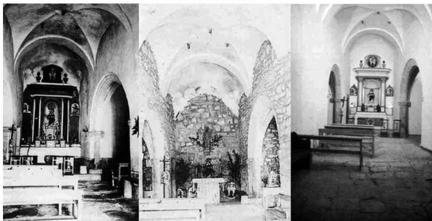
Figura 5. Iglesia de Sant Cugat de Garadons: estado original, restauración años sesenta e intervención de Antoni González (fotos: SPAL)
