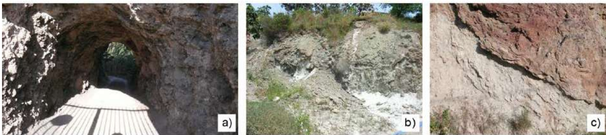
Figura 3. Afloramientos yesíferos junto a la vivienda afectada: a) Galería kárstica re trabajada artificialmente, b) Acumulaciones de sulfatos disueltos (color blanco) en un afloramiento yesífero y c) Contacto entre yesos rojizos triásicos (zona superior) y arcillas verdosas del eoceno (zona inferior).
