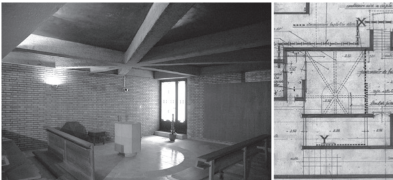
FIG. 17 Izq: Vista del cruce de vigas de hormigón visto sobre la pila bautismal y bajo la mesa del altar (Autores 2018). Dcha: Recorte del plano de oct-1965 (Fig. 8) donde se aprecia el dibujo de las ocho vigas a trazos sobre la pila Left: View of the crossing of exposed concrete beams above the baptismal font and under the altar table (Authors 2018). Right: Cut out of the plan from Oct-1965 (Fig. 8), showing the drawing of the eight beams in lines above the font.
