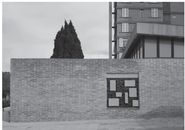
FIG. 18 Vistas del muro lateral norte con el vitral del nártex y la nave sobresaliendo (Autores 2018). Views of the north side wall with the stained glass of the narthex and the nave protruding (Authors 2018).
