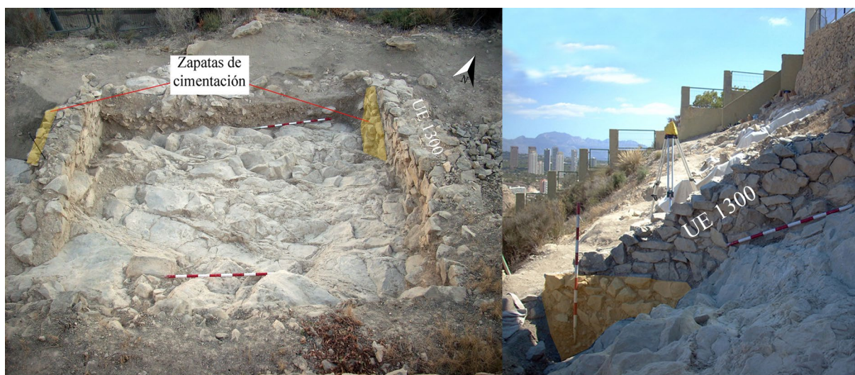
Figura 14. Zapata estructural del muro medianero de la estancia 12 en el punto de unión con la muralla (fotografía propia).
