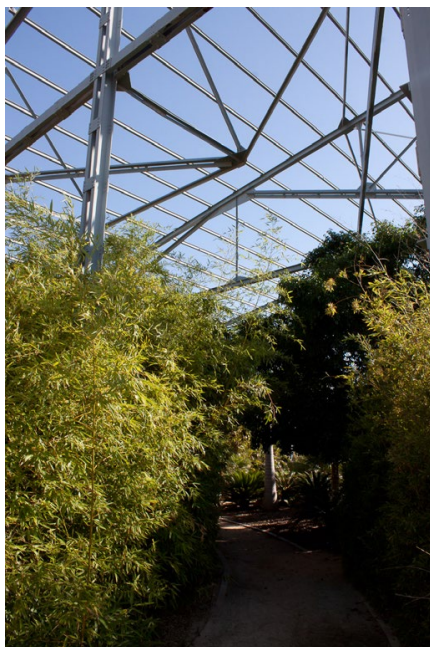
Vista actual de la estructura metálica del antiguo hangar del aeródromo de Rabassa.
