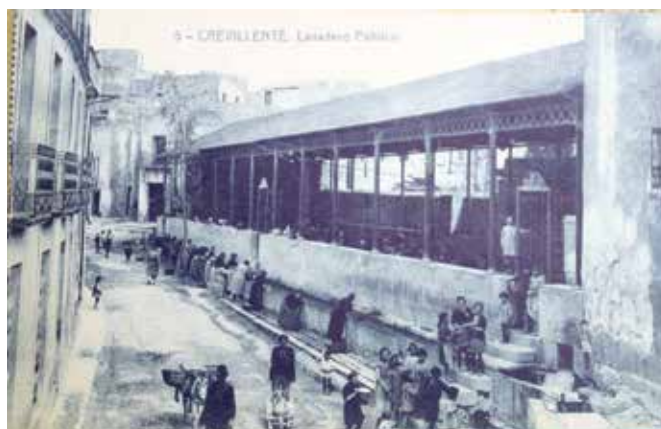
Fig. 20 Arriba el estado de la fachada en 2015, con restos del canal del antiguo lavadero -la primera de las hileras- 66 .
