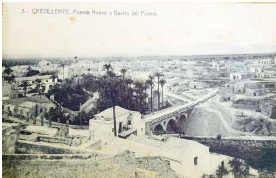
Figura 14 Postal 3. Puente Nuevo y Barrio del Puente
