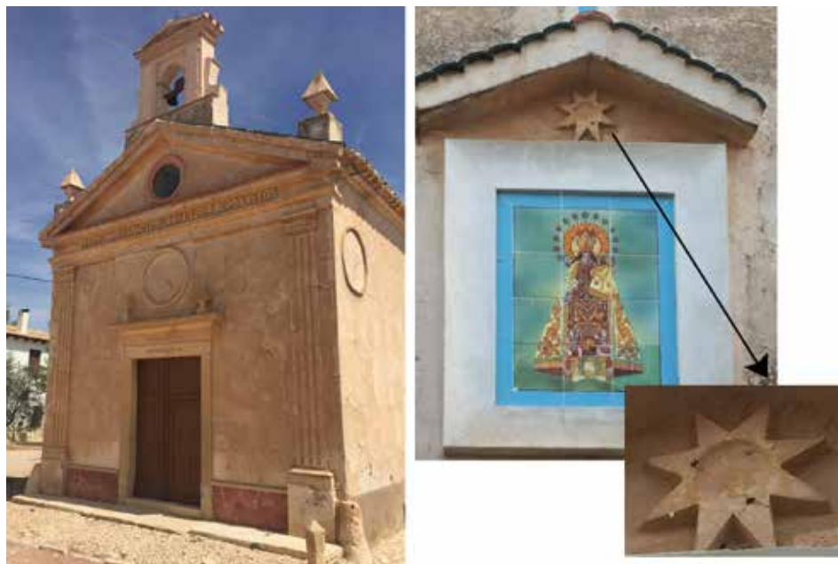
Fig. 5: Vista general de la ermita de San Blas en el Collado Azorín o Collado de Salinas y detalle del panel devocional situado en un lateral exterior de la ermita. Sobre el panel devocional se aprecia la estrella de ocho puntas o roseta esquemática. Fuente: los autores.
