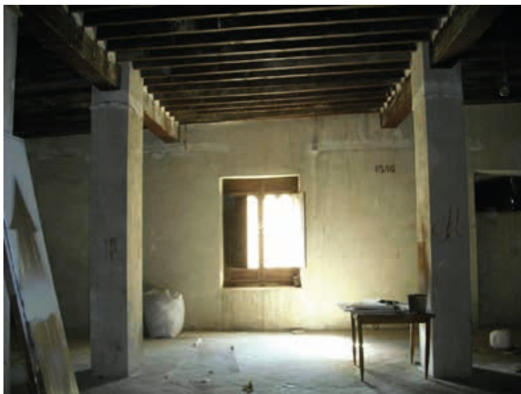
Estat actual de l'interior del edifici de 1886 de la Fàbrica Gran o de don Augusto. Manuel Carreres, 2007.
