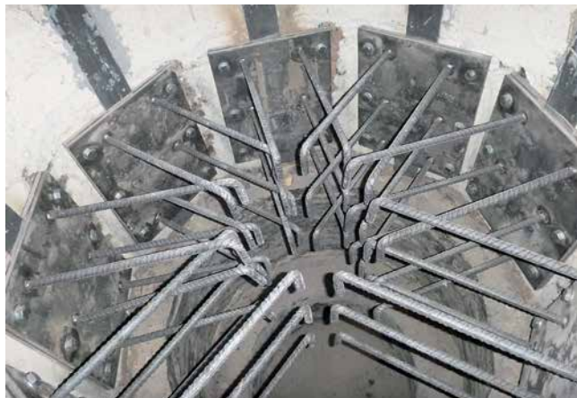
Figura 22. Anclaje FRP de cimentación.
