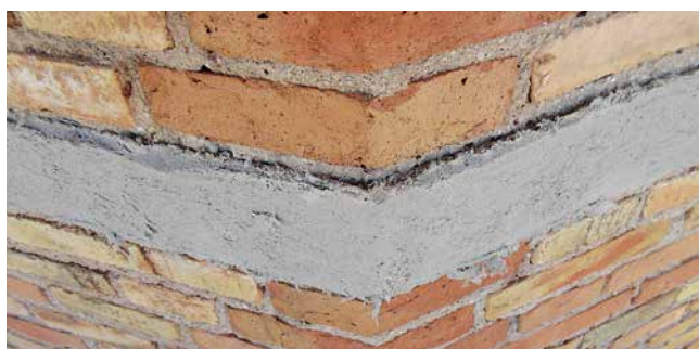
Figura 21. Aspecto final: HDM + Mapegrid.
