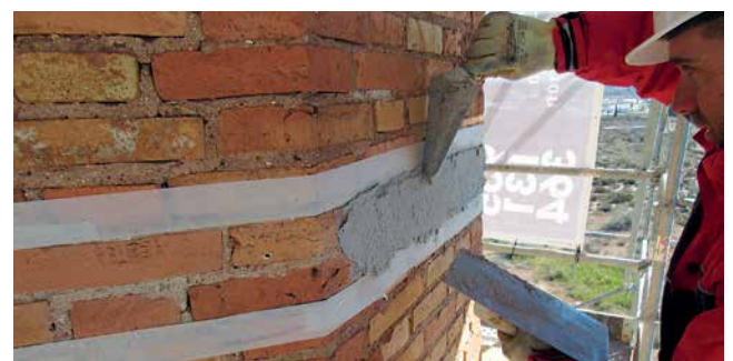
Figura 19. Primera capa de HDM Restauro.
