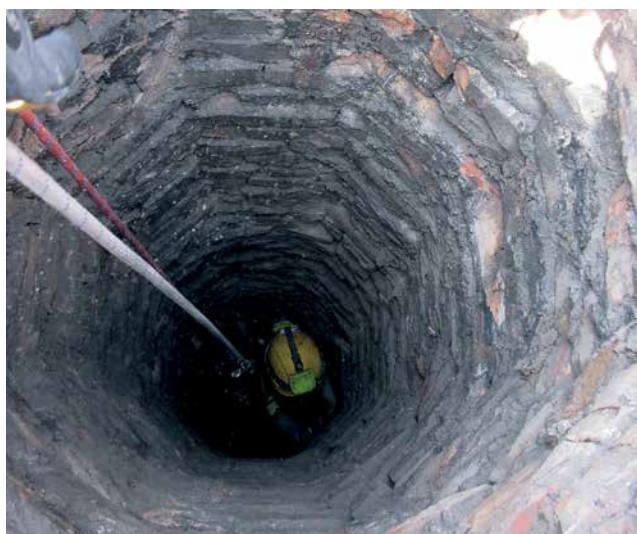
Figura 14. Limpieza y cepillado interior.
