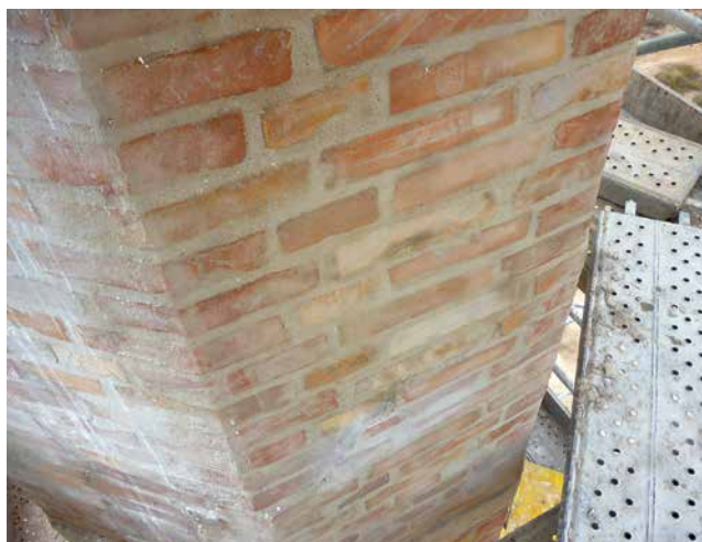
Figura 13. Rejuntado y sellado de grietas.
