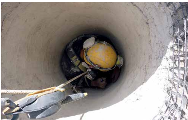
Figura 15. Trabajo en el interior.
