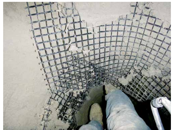
Figura 17. Colocación de Mapegrid G220.
