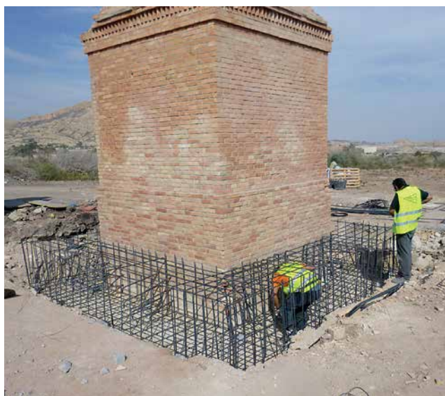
Figura 23. Vista exterior del recalce.
