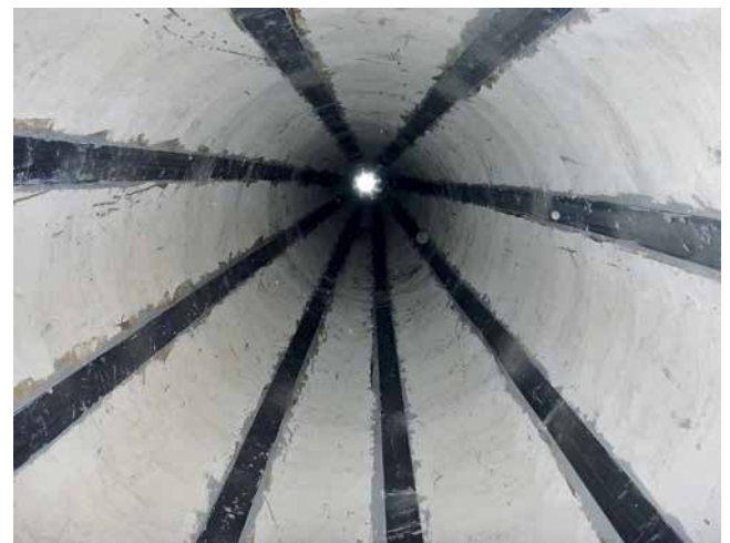
Figura 18. Refuerzos de Carboplate E170.
