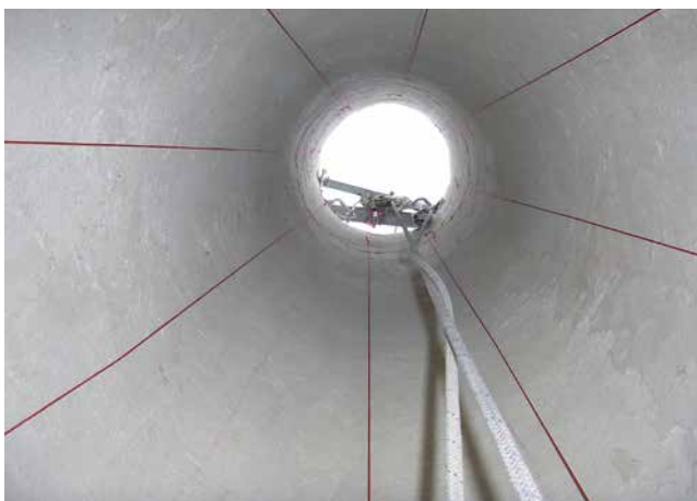
Figura 16. Replanteo de bandas FRP.
