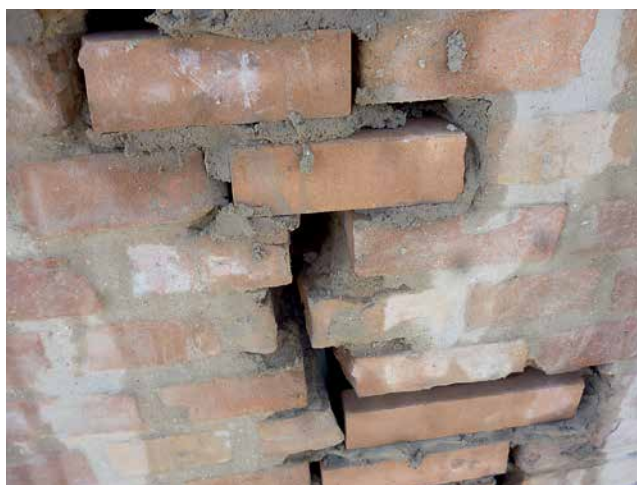
Figura 12. Sustitución de piezas dañadas.
