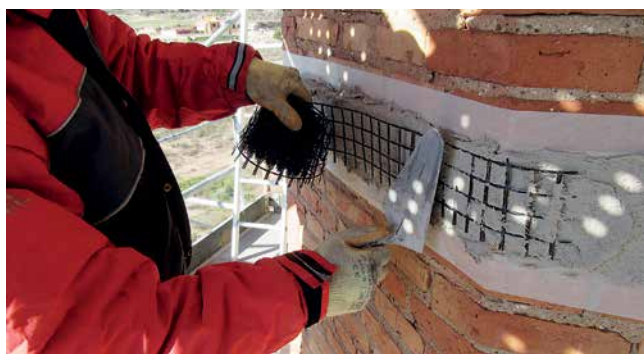
Figura 20. Colocación de Mapegrid G-220.
