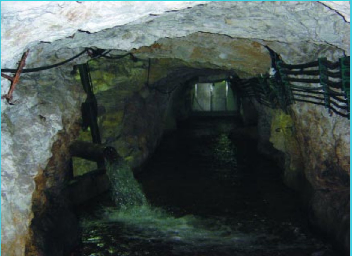
Fig. 21. Water extraction via boreholes within the Galería.
