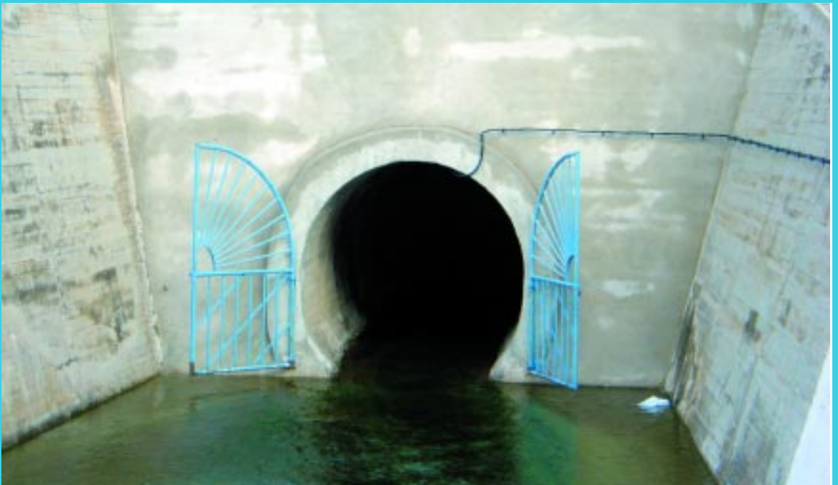
Fig. 19. Entrance to Galería de los Suizos.
