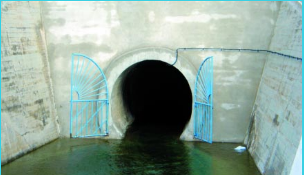
Fig. 19. Vista de la entrada de la Galería de los Suizos
