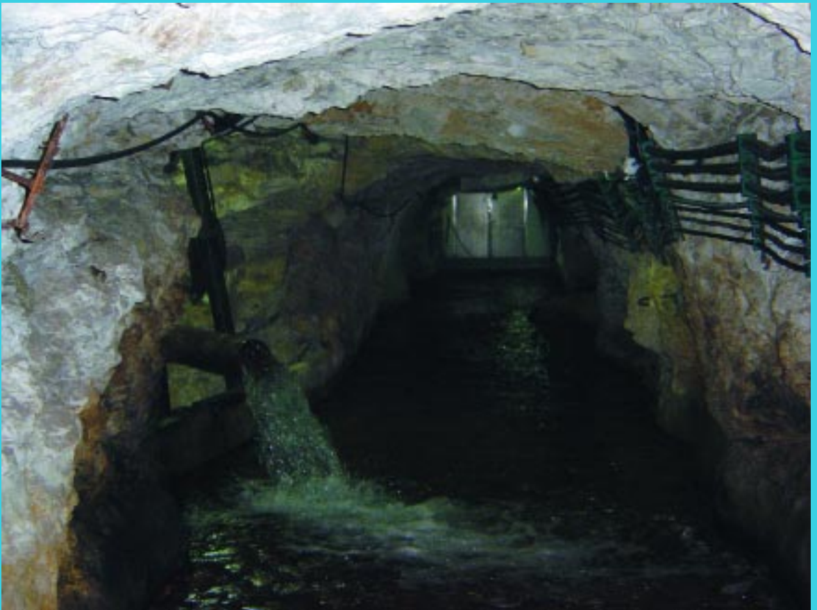
Fig. 21. Extracciones mediante sondeos en el interior de la galería.
