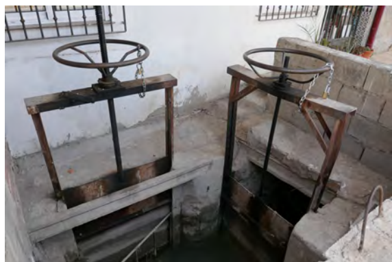
Figura 7. Partidores de La Cueva en la terminación del Azarbe de Monteagudo que da inicio a las acequias de riego denominadas Brazal Alto y Bajo de La Cueva. Fotografía: G. Canales.
