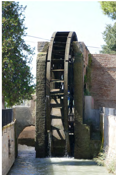
Figura 4. Rueda de La Ñora. La actual de hierro data de 1936 y sustituyó a las anteriores de madera, documentándose la primera en 1416. Fotografía: G. Canales.
