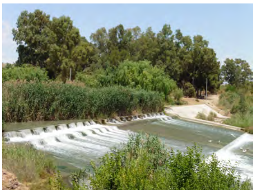
Figura 1. Azud de la Contraparada, origen de la Huerta de Murcia y el elemento fundamental del edificio hidráulico, ya que de él deriva la red de riego. Fotografía: G. Canales.
