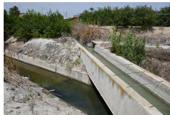
Figura 5. Espectacular encabalgamiento de la acequia Nueva del Raal sobre el Merancho del Gil. Canalización que sirvió para colonizar el marjal de La Urdienca-El Raal en el siglo XVIII. Fotografía: G. Canales.
