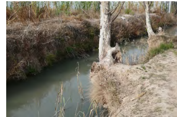
Figura 3. Detalle del Azarbe de Monteagudo. Una de las pocas arterias de la red hidráulica que muestra tramos en su estado natural, con arbolado en su quijero para evitar el desmoronamiento de tierra. Fotografía: G. Canales.
