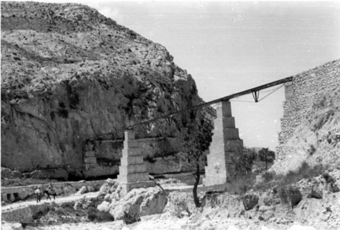
Figura 7. Canal de Ferro construido para salvar la rambla de Puça (Fuente: petreraldia).
