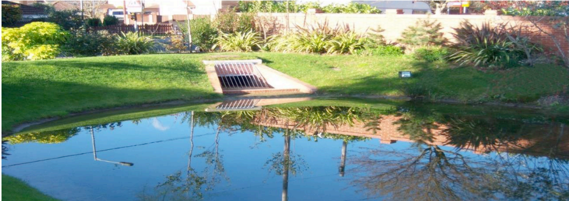
Figura 13. Depósito de detención en superficie. Fuente: www.meadfleet.co.uk .
