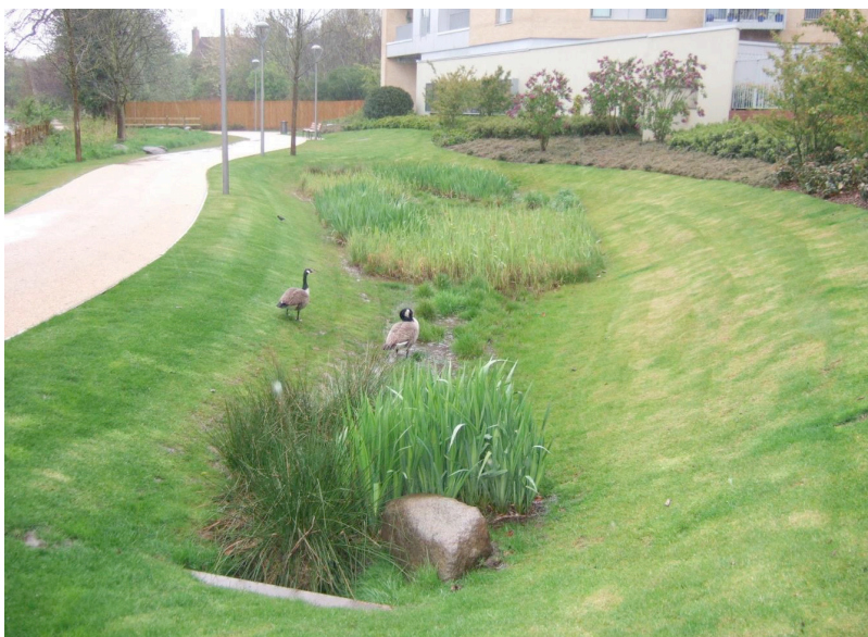
Figura 11. Cuneta verde. Fuente: www.ecologyconsultancy.co.uk .
